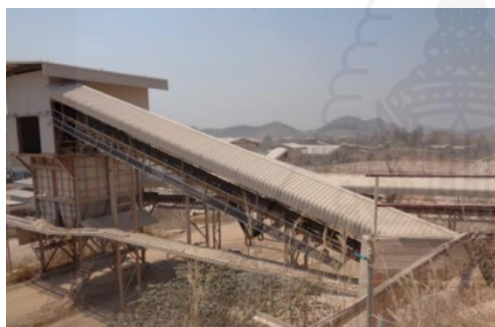
ค. หลังคาปิดคลุมสายพานลำเลียง
