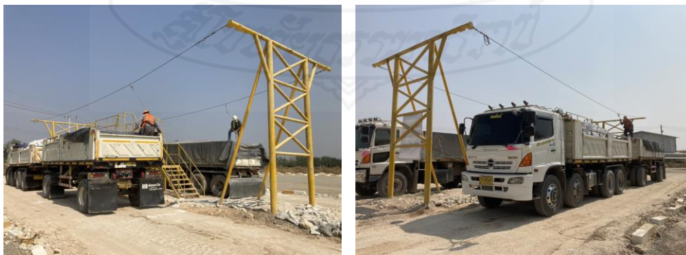
ภาพที่ 36 การนำเทคโนโลยี Fall body harness มาใช้ในการคลุมผ้าใบรถบรรทุกก่อนออกจาก เขตประถานบัตร เพื่อลดอุบัติเหตุหรือความบาดเจ็บจากการปฏิบัติงานของคนงาน
