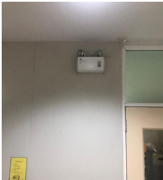
ภาพที่ 5 ตัวอย่างไฟส่องสว่างและไฟฉุกเฉินภายในโรงพยาบาล
