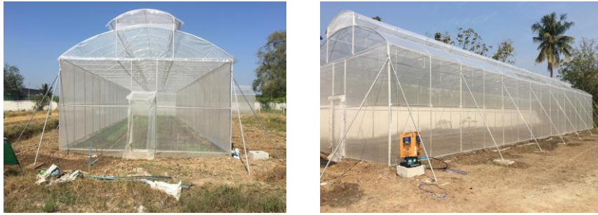
ภาพที่ 2.2 ลักษณะ โรงเรือนปลูกผักหลังคาทรงจั่ว
