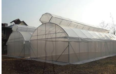
ภาพที่ 2.4 โรงเรือนหลังคาหน้าจั่วสองชั้น
