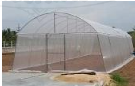
ภาพที่ 2.5 โรงเรือนหลังคาทรงหลังคาโค้งแบบเสาเอียง
