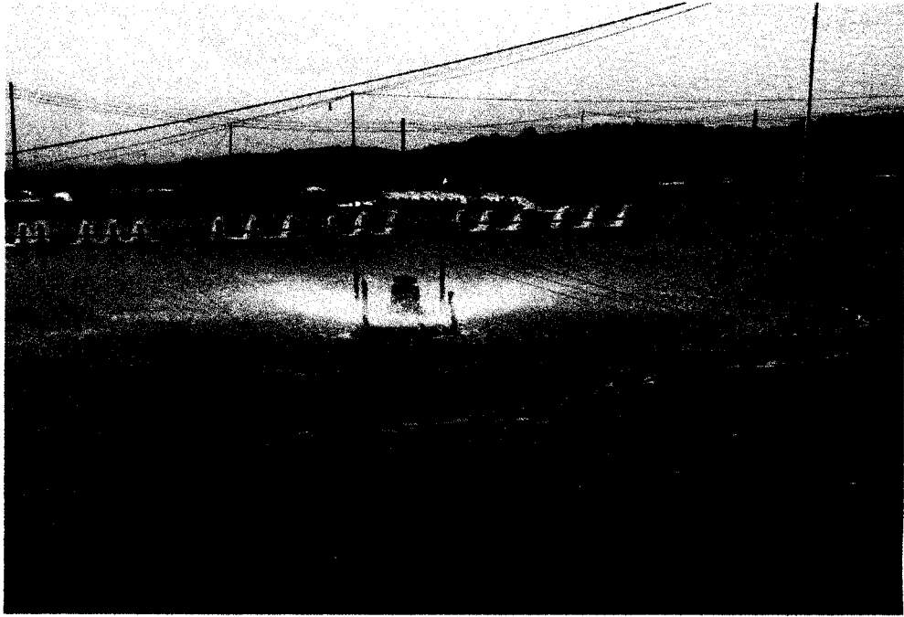
ภาพผนวกที่ 1.3 บ่อเลี้ยงกุ้งขาวแวนนาไมที่มีเครื่องตีน้ำ และมีการเสริมเครื่องให้อากาศ
