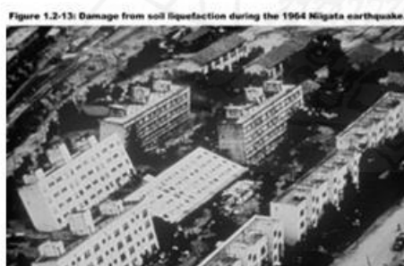
พื้นที่ที่รองรับด้วยชั้นดินทรายที่อิ่มตัวด้วยน้ำ จะเปลี่ยนสภาพเสมือนของเหลว (Liquefaction) เมื่อมีแผ่นดินไหวขนาดใหญ่ ทำให้อาคารทรุดจมลงในดิน จากเหตุการณ์แผ่นดินไหว ค.ศ.1964 ที่ญี่ปุ่น
