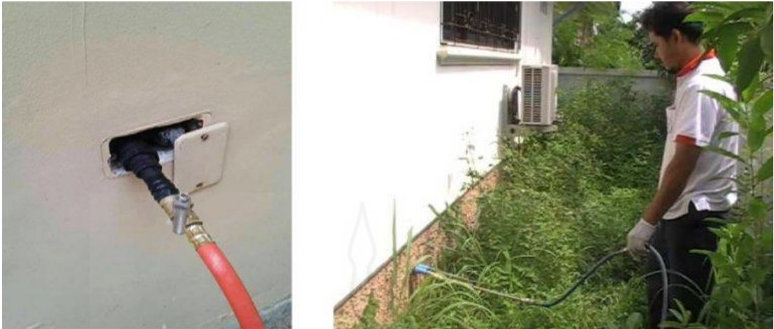
ภาพที่ 2.4 ขั้นตอนการอัดสารเคมีชนิดน้ำ เข้าท่อ (วางท่อกำจัดปลวก)
