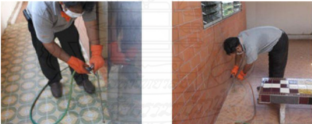
ภาพที่ 2.3 ขั้นตอน การเจาะพื้นเพื่ออัดสารเคมี ชนิดน้ำ ลงใต้พื้นบ้าน หรืออาคาร
