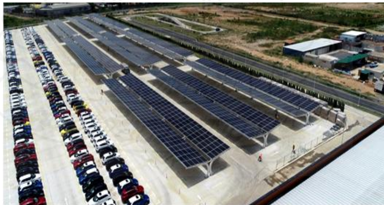
ภาพที่ 14 การติดตั้งแผงโซลาร์เซลล์บนหลังคาที่จอดรถ (Solar Carpark) ที่มา : บริษัท ดับบลิวเอชเอ ยูทิลิตี้ส์ แอนด์ พาวเวอร์ จำกัด (มหาชน) (ม.ป.ป.)
