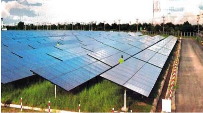
ภาพที่ 12 การติดตั้งแผงโซลาร์เซลล์บนพื้นดิน (Solar Farm)
