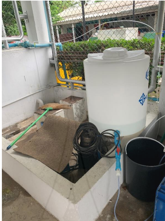
จุดเติมสารฆ่าเชื้อดัดสยกรดเปอร์อะซิติก
