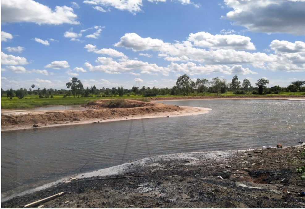
ภาพที่ 2.7 สภาพคันคูบ่อเก็บกักน้ำป้องกันน้ำเสียแพร่กระจายสู่ภายนอก
