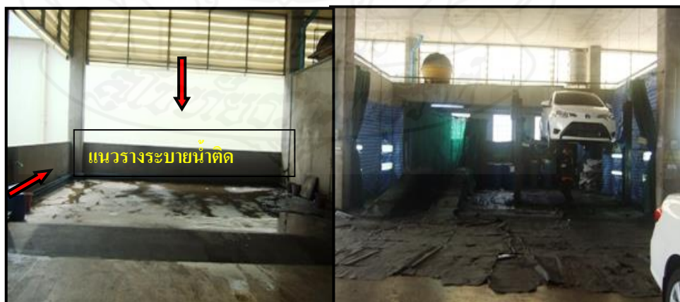
ภาพที่ 3.6 รางระบายน้ำด้านข้างพื้นที่พ่นกันสนิม และตะแกรงดักตะกอน ที่มา : บริษัท โตโยต่านนท์บุรี ผู้จำหน่ายโตโยต้า จำกัด (2564)
