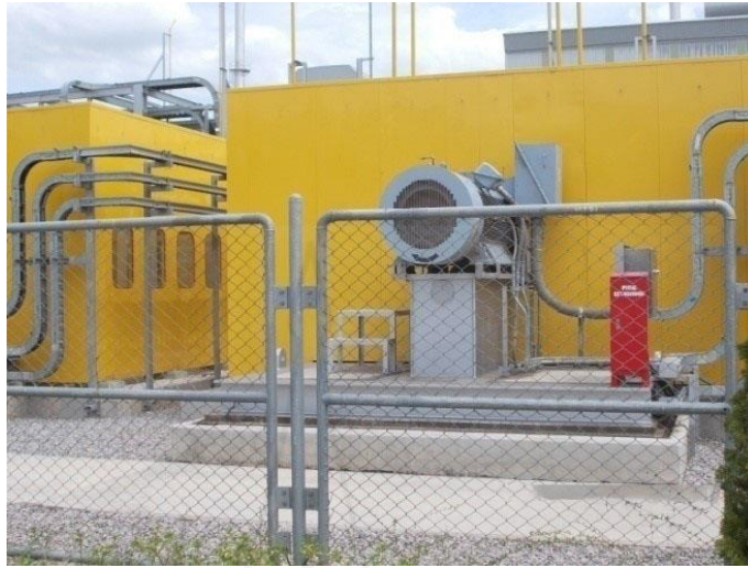
ภาพที่ 5.19 อาคารปิดครอบเครื่องจักรที่มีระดับเสียงเกิน 85 เดซิเบล (เอ) ที่มา : บริษัท เอ็นไวรอนเมนท์รีเสิร์จ แอนด์ เทคโนโลยี จำกัด (2561, น. 86)
