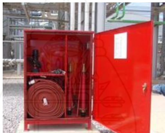
ภาพที่ 5.55 อุปกรณ์สำหรับการดับเพลิง ที่มา : บริษัท เอ็นไวรอนเมนท์ รีเสิร์จ แอนด์ เทคโนโลยี จำกัด (2561,น. 92)
