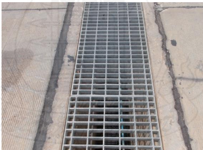
ภาพที่ 5.9 วางระบายน้ำฝนที่ตกในพื้นที่ทั่วไปรอบโรงงาน ที่มา : บริษัท เอ็นไวรอนเมนท์ รีเสิร์จ แอนด์ เทคโนโลยี จำกัด (2561, น.84)
