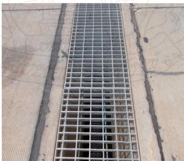
ภาพที่ 5.33 รางระบายน้ำฝนที่ไม่มีการปนเปื้อน
