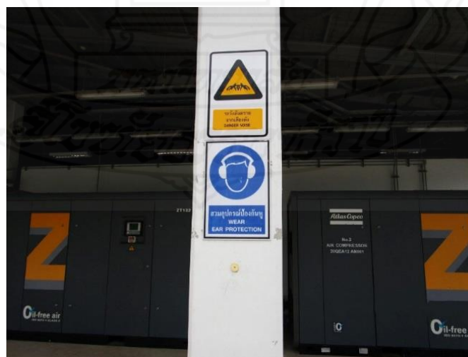
ภาพที่ 5.19 ป้ายเตือนในบริเวณที่มีระดับเสียงดังเกิน 85 เดซิเบล (เอ) ที่มา : บริษัท เอ็นไวรอนเมนท์รีเสริจ แอนด์ เทคโนโลยี จำกัด (2561,น. 86)
