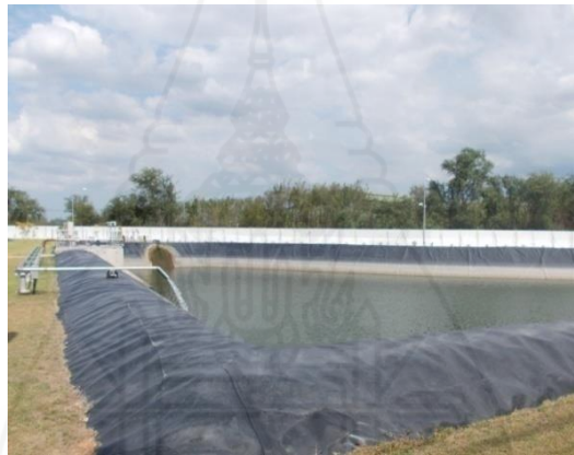
ภาพที่ 5.14 บ่อบำบัดน้ำทิ้งโครงการ
