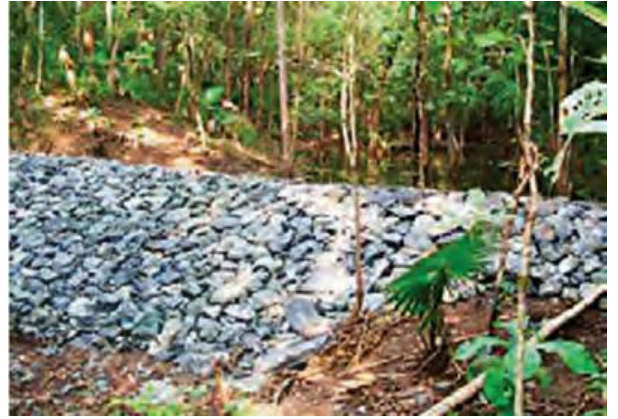
ฝายแบบเรียงด้วยหินค่อนข้างถาวร
