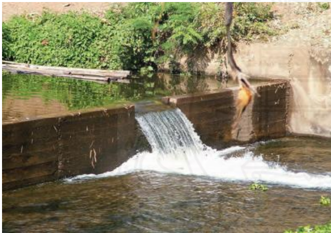
ฝายแบบคอนกรีตเสริมเหล็ก
