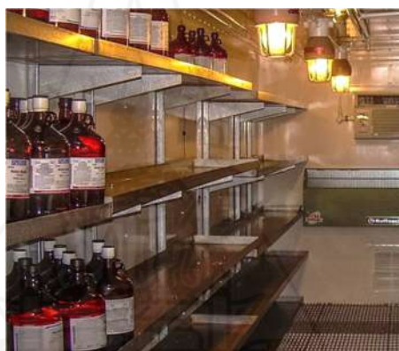
ภาพที่ 4.22 ตัวอย่างการใช้หลอดไฟที่สามารถป้องกันการระเบิดภายในสถานที่เก็บรักษาสารเคมีอันตราย
