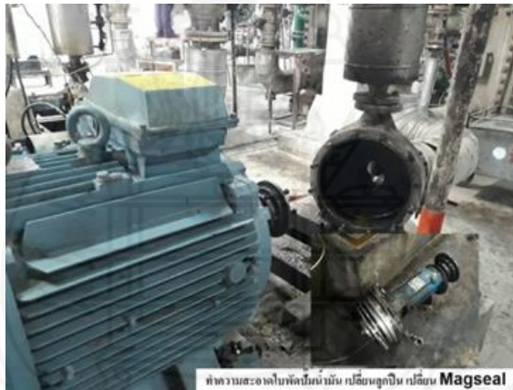
ภาพที่ 4.3 เปลี่ยนลูกปืนและ แมคคานิคอลซีล (mechanical seal) ของปั้มน้ำ
