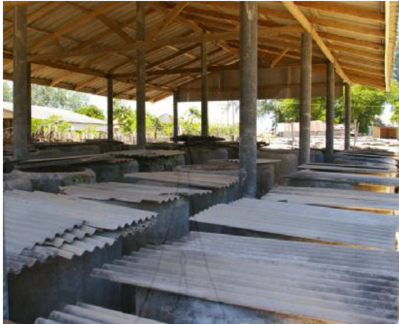
ภาพที่ 410 ภาพบ่อหมักน้ำมูลในที่ร่ม ซึ่งสร้างโรงเรือนครอบไว้ โดยเปิดโล่งทั้งสี่ด้าน ถ่าย ณ. โรงผลิตน้ำมูลของคุณต่วนยาริยะ การิสุหลง
