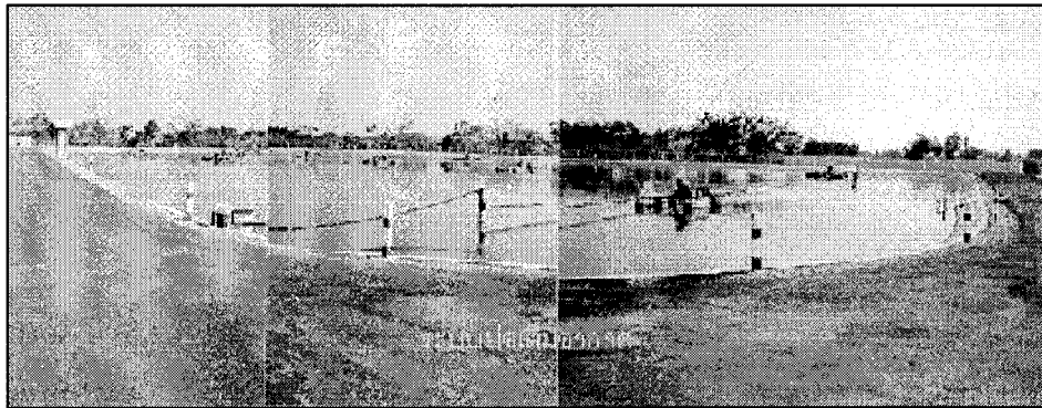
ภาพที่ 2.5 บ่อเติมอากาศ (Aerated Lagoon หรือ AL)
