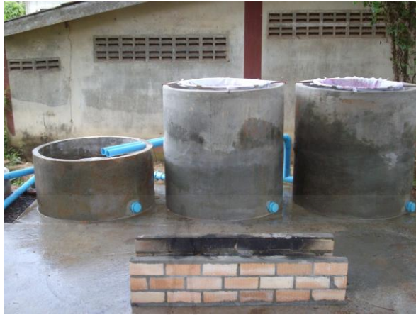
ภาพที่ 5.1 บ่อซีเมนต์เพื่อเก็บน้ำเสียจากการข้อมลึกระจูด
