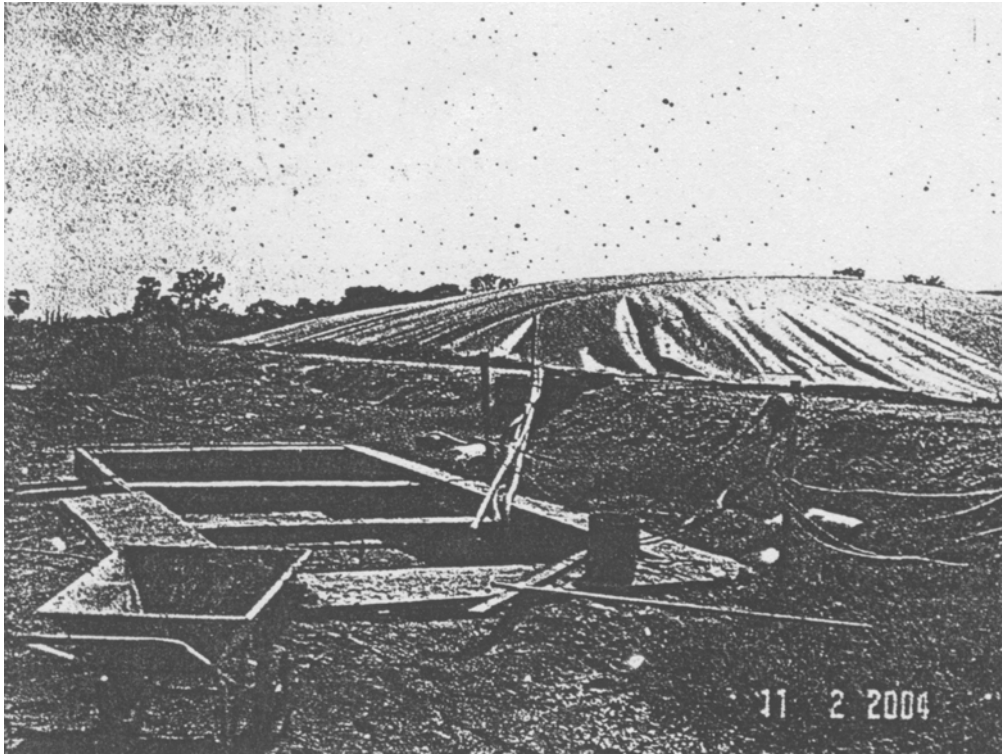
บ่อพักน้ำเสียบกับบ่อ ไบโอดีแก็ซระบบลาดูน
