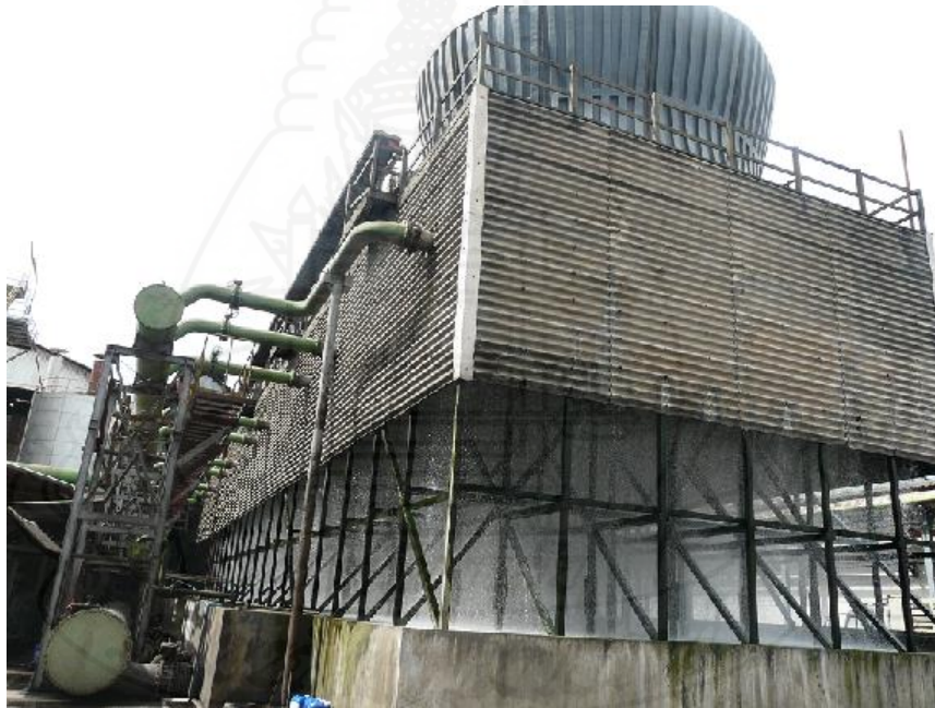
ภาพที่ ค.11 หอน้ำหล่อเย็น
