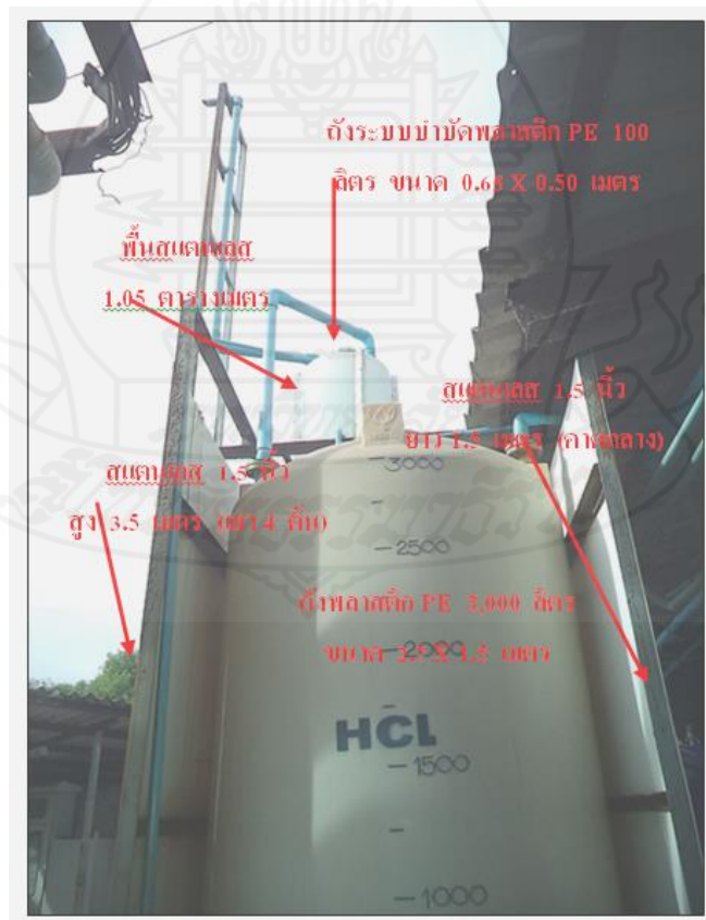
ภาพที่ 4.4 งานโครงสร้างแท็งก์ HCl
