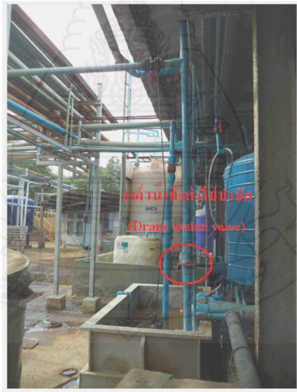
ภาพที่ 4.7 การติดตั้งงานระบบวาล์วน้ำทิ้งส่งไปบำบัด
