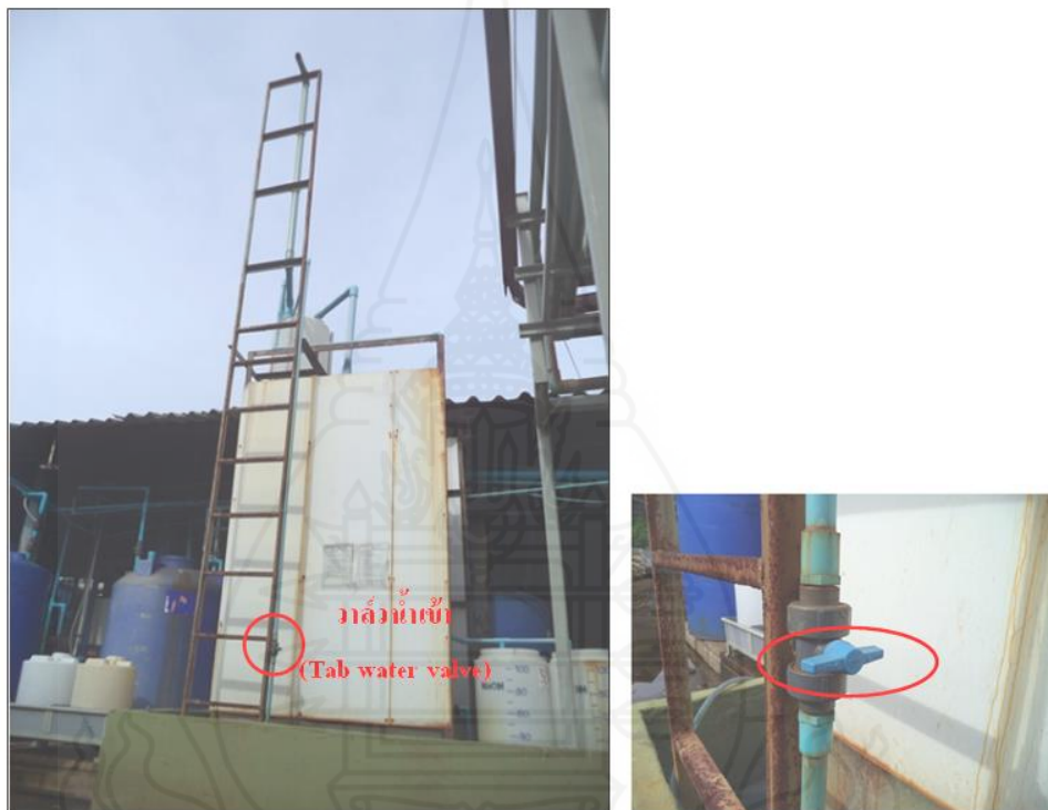
ภาพที่ 4.6 การติดตั้งงานระบบวาล์วน้ำเข้า
