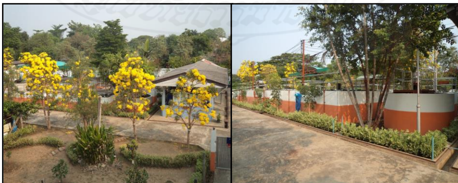
ภาพที่ 2.17 ระบบบำบัดน้ำเสียแบบแอกทิเวเต็ดสลัดจ์ของโรงพยาบาลพระนครศรีอยุธยา
