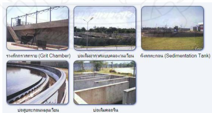
ภาพที่ 2.12 หน่วยบำบัดย่อยในระบบบำบัดน้ำเสียแบบคลองวนเวียน
