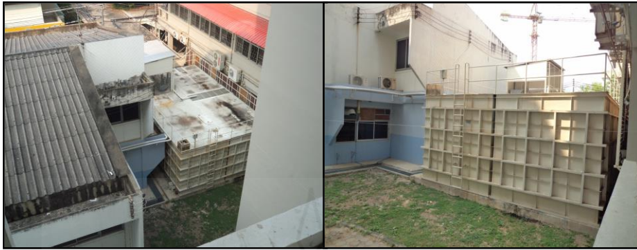
ภาพที่ 2.35 ระบบบำบัดน้ำเสียแบบชีวภาพผสม โรงพยาบาลพระนครศรีอยุธยา
