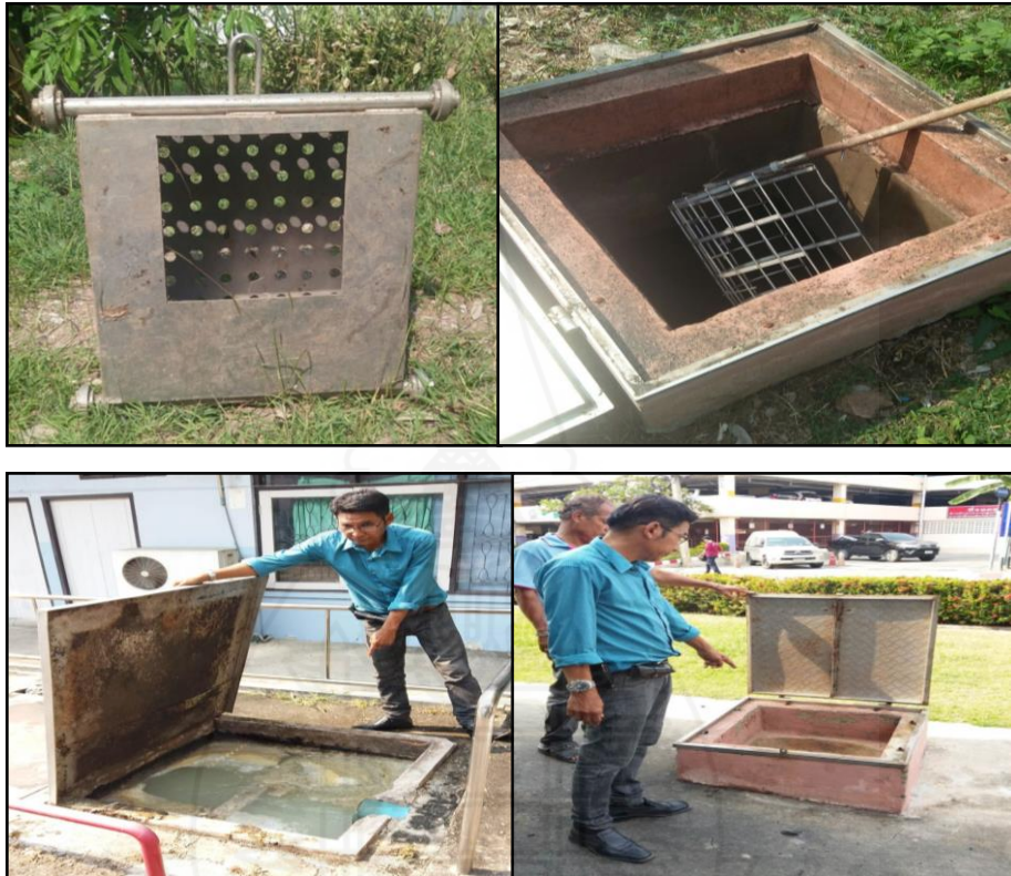
ภาพที่ 2.18 บ่อดักไขมันบริเวณอาคารศรีอโยธยา โรงพยาบาลพระนครศรีอยุธยา
