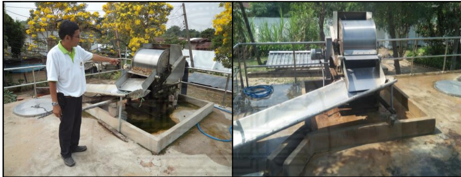
ภาพที่ 2.21 ตะแกรงแยกเศษวัสดุขนาดเล็ก (Rotary Drum Screen)
