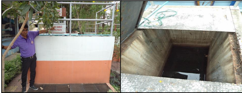
ภาพที่ 2.32 บ่อเก็บน้ำตะกอน (Fil Trate Sump)
