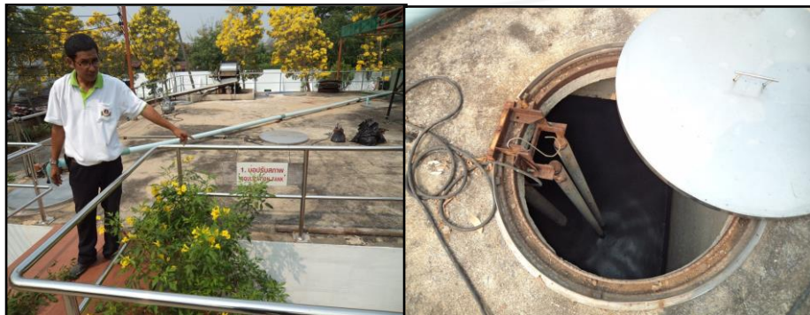
ภาพที่ 2.22 บ่อปรับสภาพสมดุล (Equalization Tank)
