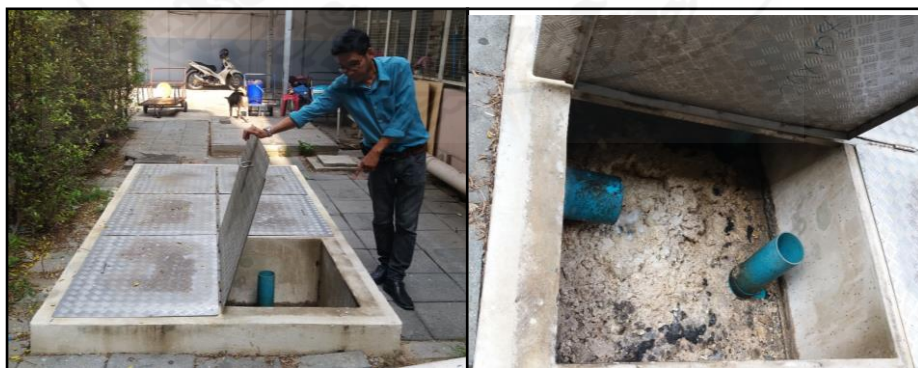
ภาพที่ 2.19 บ่อดักไขมันบริเวณอาคารสวนอุตสาหกรรม โรงนะ โรงพยาบาลพระนครศรีอยุธยา
