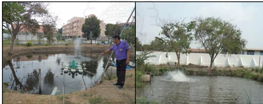
ภาพที่ 2.33 บ่อปรับเสถียรแบบธรรมชาติ (บ่อฝิ่งธรรมชาติ)
