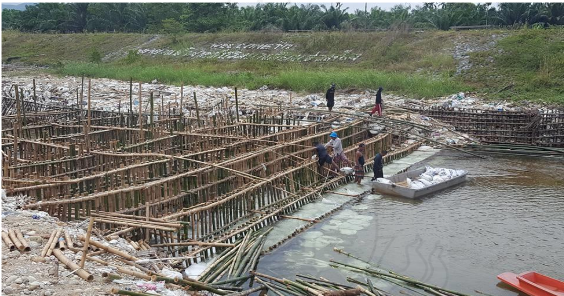
ภาพที่ 4.1 การก่อสร้างฝายมีชีวิต
