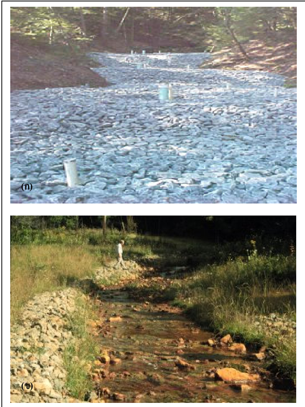
ภาพที่ 4.14 ระบบการบำบัดแบบ Open Limestone Channels (OLCs) (Skousen, J. G., 2001)
