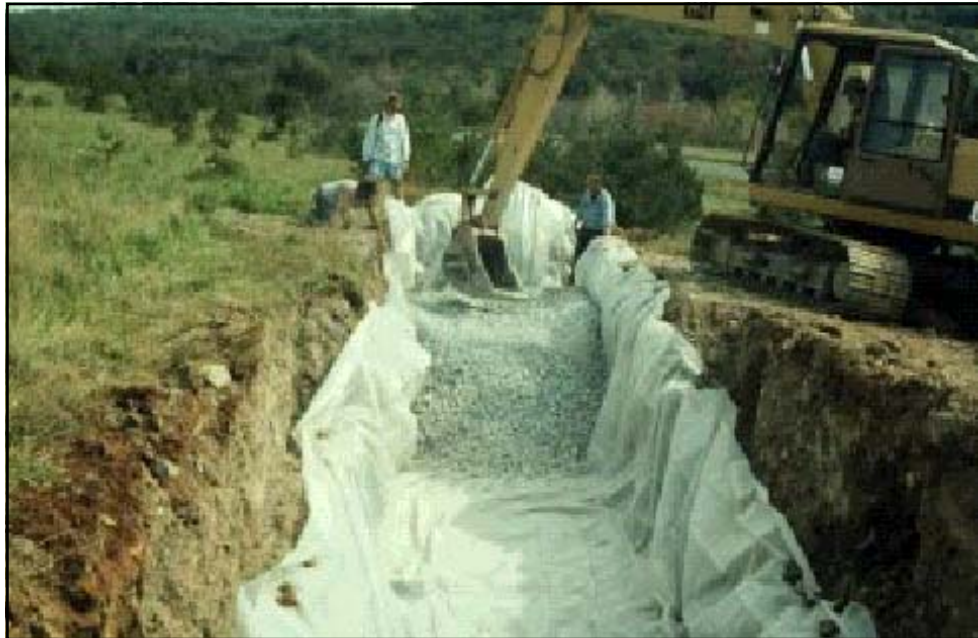
ภาพที่ 4.8 ระบบการบำบัดแบบ Anoxic Limestone Drains (ALDs) (Skousen, J. G., 2001)
