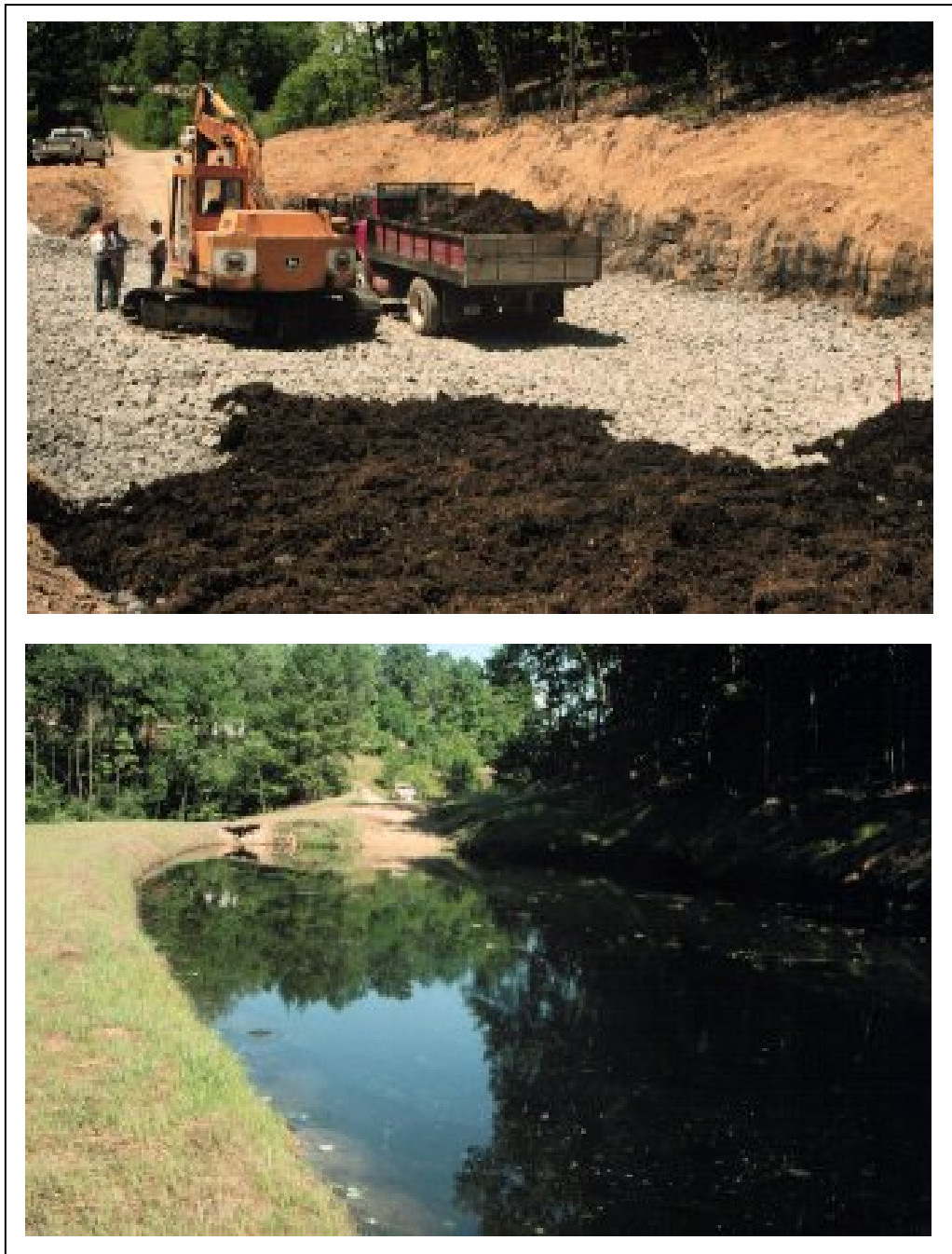
ภาพที่ 4.10 ระบบบำบัดแบบ Successive Alkalinity Producing Systems (SAPs)
