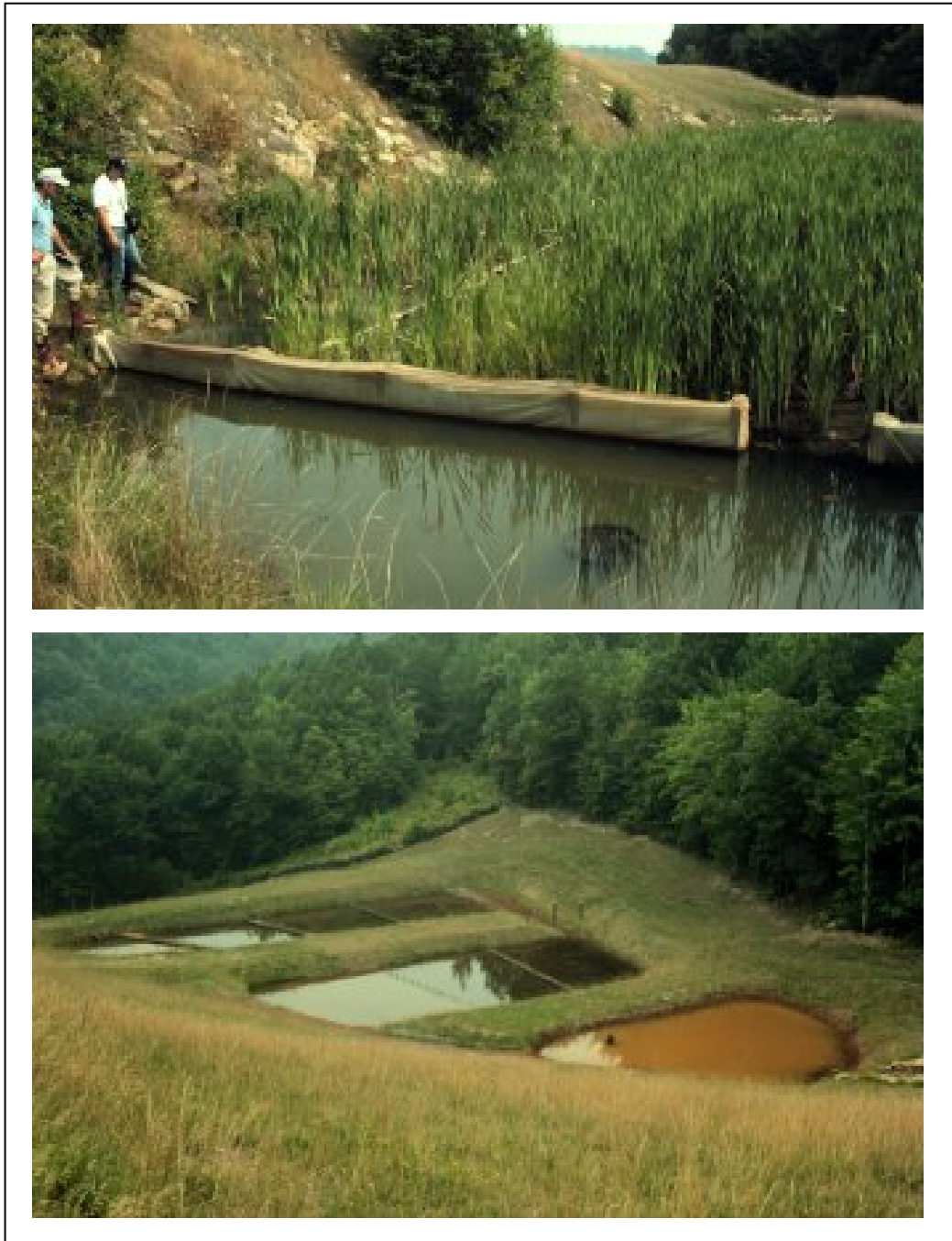
ภาพที่ 4.6 ระบบบำบัดแบบ Anaerobic Wetlands (Skousen, J. G., 2001)
