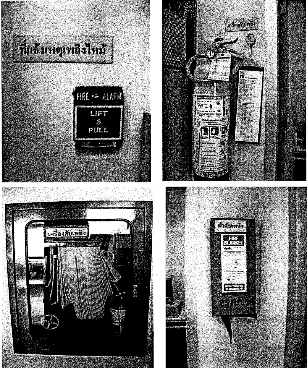
ภาพที่ 4.4 อุปกรณ์แจ้งเหตุด้วยมือและอุปกรณ์ดับเพลิงบริเวณแผนกต้อนรับพยาบาล หอผู้ป่วยสก.19 ผ่าตัดหัวใจ
