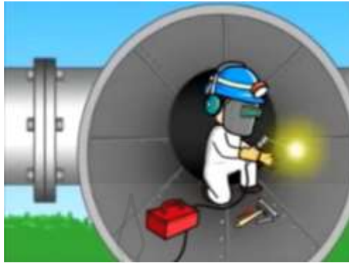
งานที่ก่อประกายไฟต้องมั่นใจว่าอยู่ในบรรยากาศที่ไม่อันตราย
