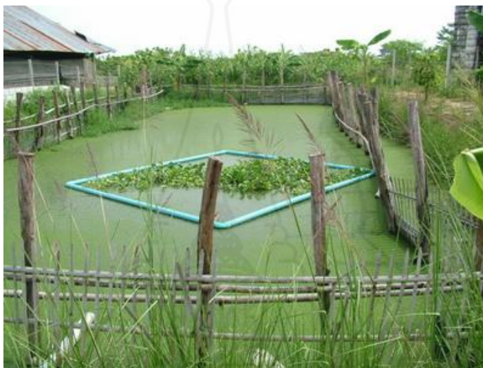
ภาพที่ 2.19 แสดงปลูกพืชลอยน้ำเพื่อช่วยดูดซับธาตุไนโตรเจนและฟอสฟอรัสในน้ำเสีย
