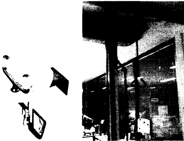
ภาพที่ 3.9 อ่างล้างตา และที่ล้างตัวฉุกเฉิน
