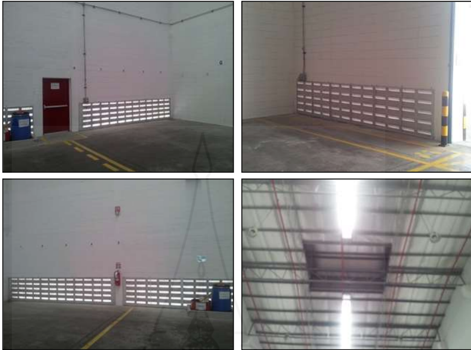
ภาพที่ 1.7 ระบบระบายอากาศของอาคารเก็บรักษาวัตถุอันตราย
