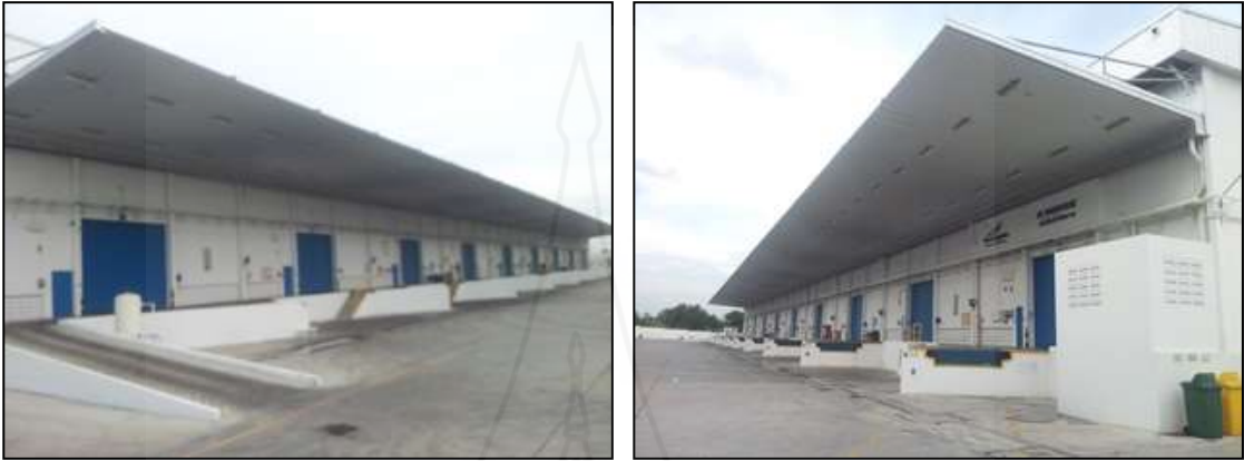
ภาพที่ 1.3 ลักษณะอาคารเก็บรักษาวัตถุดิบอันตราย
