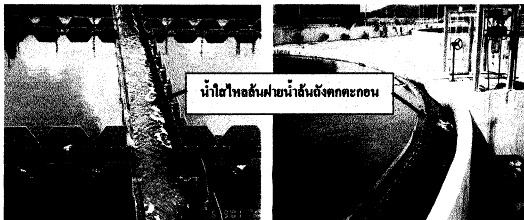
ภาพที่ 4.39 แสดงน้ำใสไหลผ่านฝายนอกถังตกตะกอน
