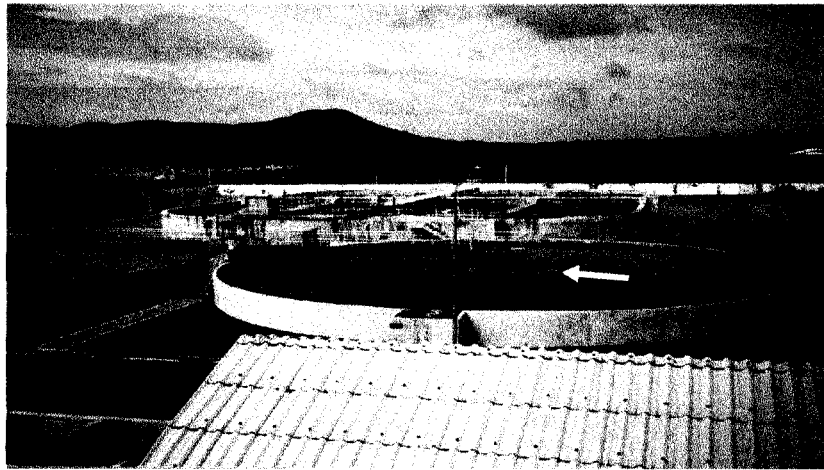
ภาพที่ 4.38 แสดงถังตกตะกอนแบบถังกลม และถังกั้นขวางตะกอน
