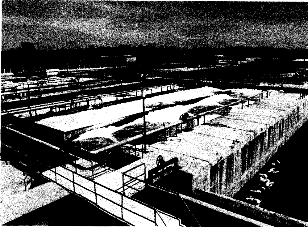
ภาพที่ 6.4 แสดงปัญหาการมีฟองขาว หนาปกคลุมผิวน้ำในถังเติมอากาศของระบบเอเอส ที่มา : สมพงษ์ หิรัญมาศสุวรรณ. เทคโนโลยีการบำบัดน้ำเสีย. (ซีดีรอม)
