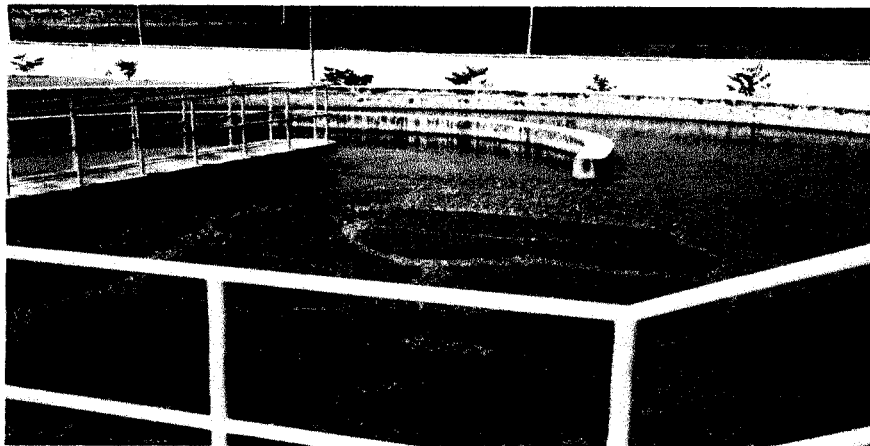
ภาพที่ 6.5 แสดงปัญหาการมีฟองสีน้ำตาล ปกคลุมผิวน้ำในถังเติมอากาศของระบบเอส ที่มา : สมพงษ์ หิรัญมาศสุวรรณ. เทคโนโลยีการบำบัดน้ำเสีย. (ซีดีรอม)
