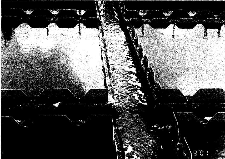
ภาพที่ 4.26 แสดงฝายน้ำล้นของอ่างตกตะกอนแบบสี่เหลี่ยม
