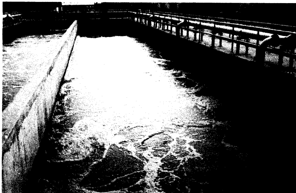
ภาพที่ 6.7 แสดงปัญหาฟองอากาศมีขนาดใหญ่และเกิดขึ้นเป็นบางจุด ที่มา : สมพงษ์ หิรัญมาศสุวรรณ. เทคโนโลยีการบำบัดน้ำเสีย. (ซีดีรอม)
