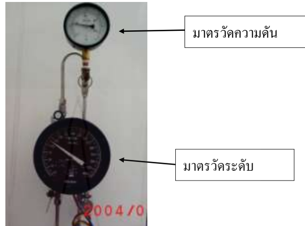
ภาพที่ 6.4 มาตรวัดระดับของถังบรรจุก๊าซเหลว
