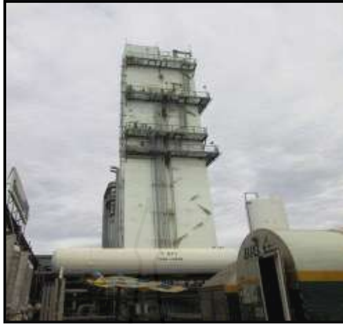
ภาพที่ 3.17 หอกลิ้นอากาศ (Columns)
