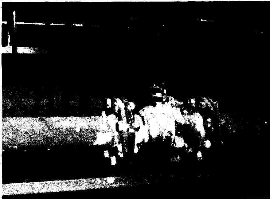
ภาพที่ 7 การติดน๊อตระหว่างท่อสำหรับเดินแก๊ส
