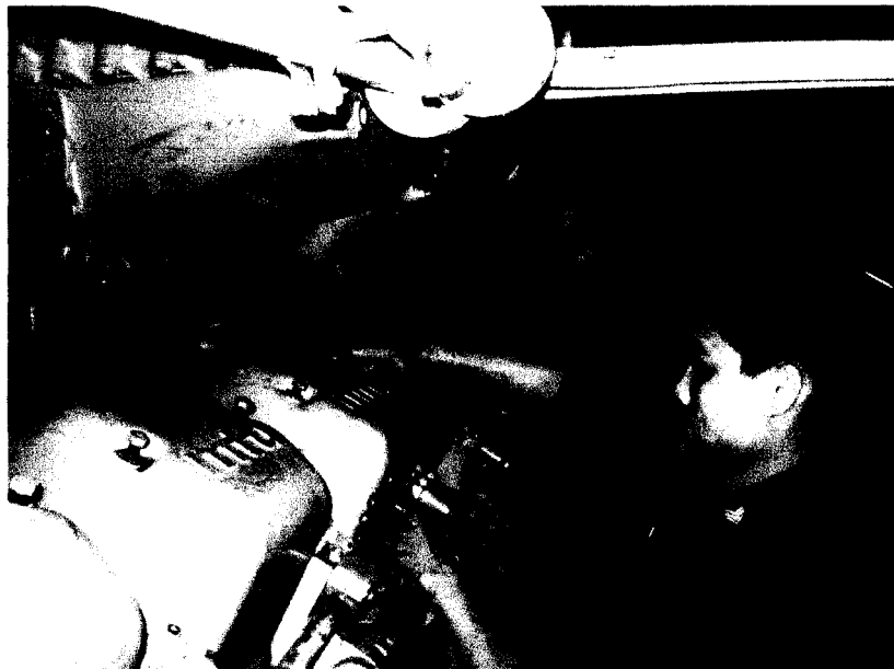
รูปที่ 11 แสดงสภาพแวดล้อมในการทำงานซ่อมบำรุงเครื่องจักร
