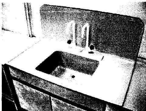
ภาพที่ 4.12 แสดงอ่างล้างอุปกรณ์ (Laboratory sink)
