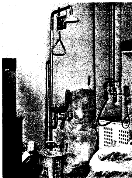
ภาพที่ 5.5 แสดงอ่างล้างตา และที่ล้างตัวฉุกเฉินในปัจจุบัน
