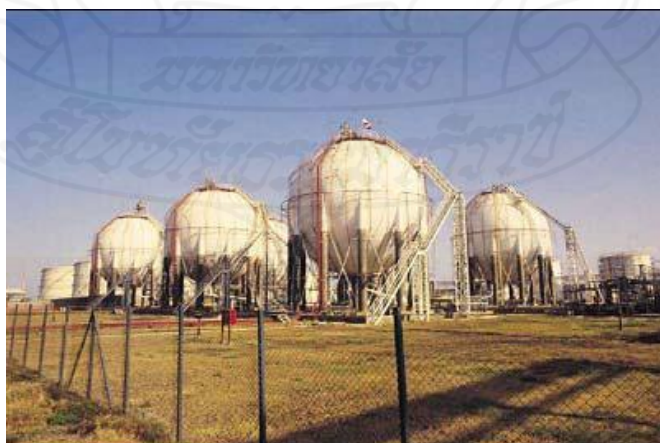
ภาพที่ 4.7 ถังเก็บทนความดันทรงกลม (Spheres)
