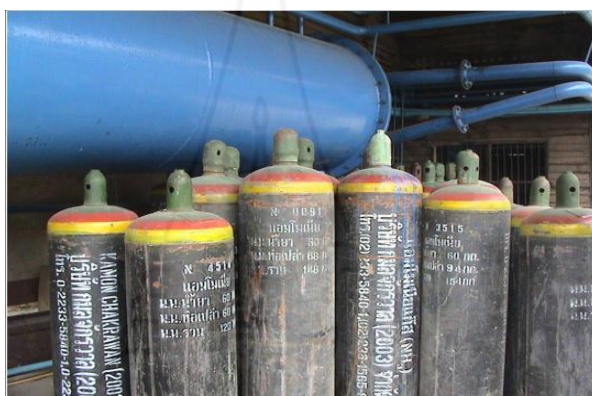
ภาพที่ 4.8 ท่อบรรจุก๊าซ (Cylinders)
