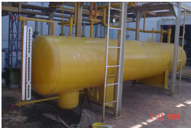
ภาพที่ 4.6 ถังเก็บขนาดใหญ่อุณหภูมิต่ำ ณ ความดันบรรยากาศ
