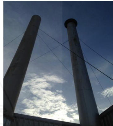
ภาพที่ 3.15 ปล่องปล่อยควันจากหม้อไอน้ำ จำนวน 2 เครื่อง
