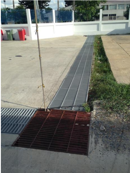
ภาพที่ 3.13 รางระบายน้ำฝนกับรางระบายน้ำเสียใช้ร่วมกัน
