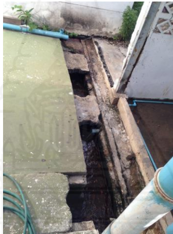
ภาพที่ 3.12 น้ำเสียที่เกิดจากการใช้งานของห้องน้ำ
