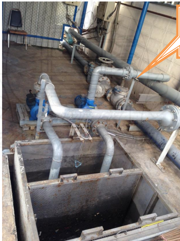
ภาพที่ 3.14 สถานีสูบน้ำเสียส่งไปยังบ่อบำบัดน้ำเสียของนิคม
