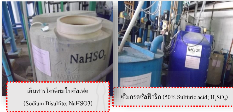
ภาพที่ 4.13 การเติมสารเคมีที่ใช้ในการบำบัด
