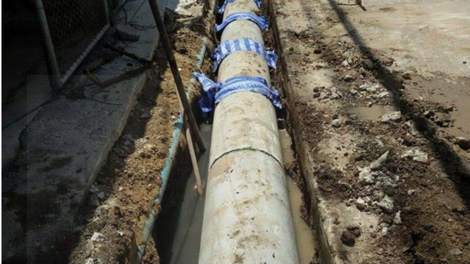
ภาพที่ 4.3 การรื้อย้ายท่อระบบระบายน้ำ
