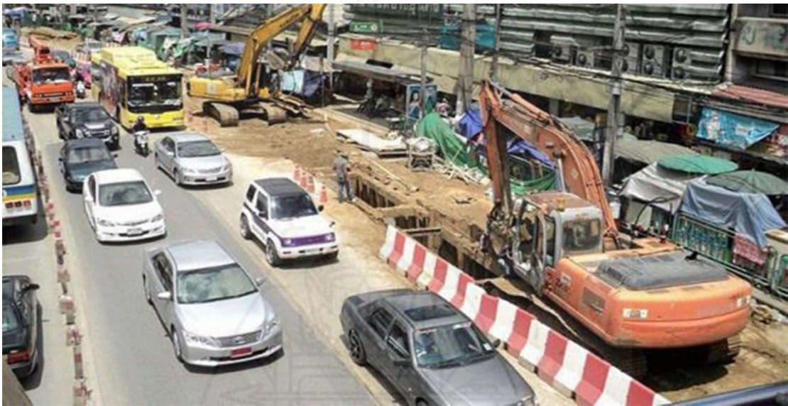
ภาพที่ 2.2 การรื้อย้ายสาธารณูปโภค (Facility Demolition)
