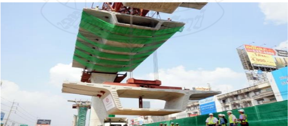
ภาพที่ 2.8 การยกและติดตั้งคานรองรับพื้นรางรถไฟ (Segment)
