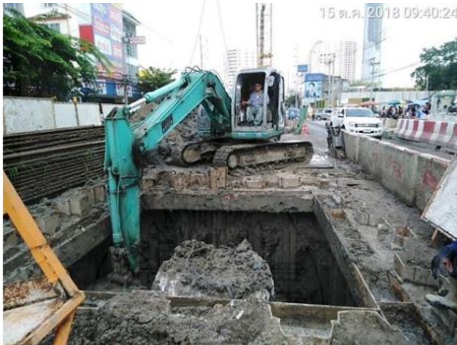
ภาพที่ 4.4 ความปลอดภัยในการทำฐานราก (Foundation Construction Safety)
