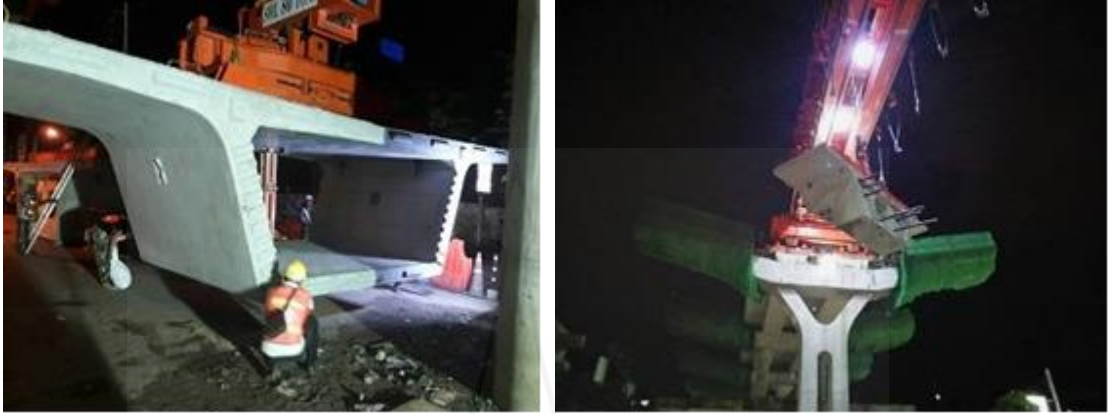
ภาพที่ 3.8 งานยกและติดตั้งคานรองรับพื้นรางรถไฟ (SEGMENT)
