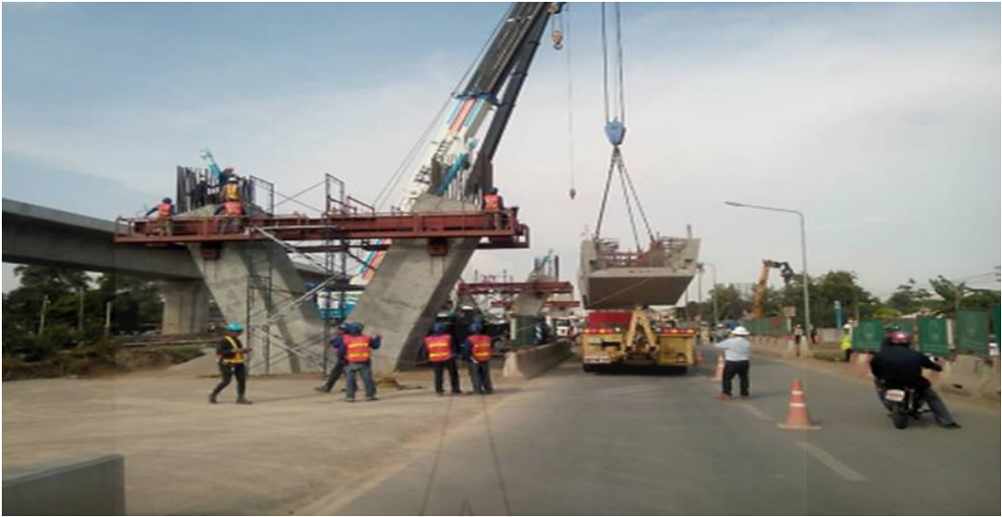
ภาพที่ 2.7 การยกและติดตั้งคานขวางสำเร็จรูป (Cross Beam)
