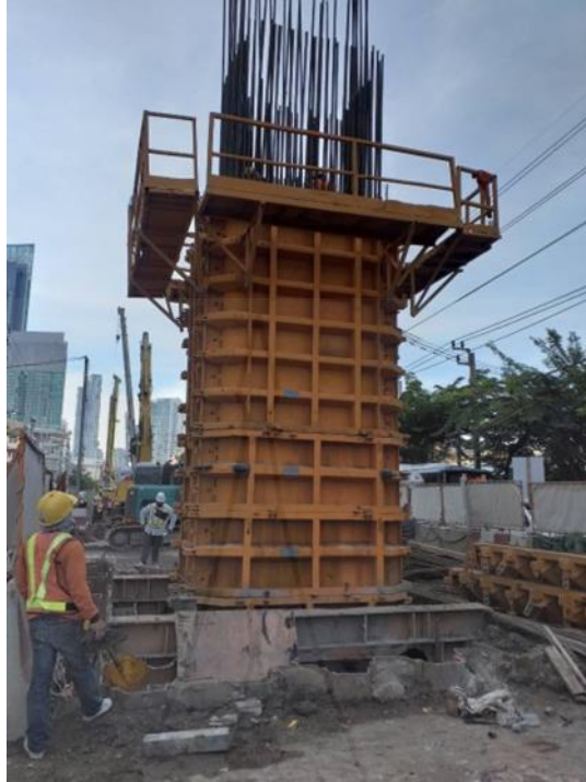
ภาพที่ 2.6 การก่อสร้างเสา (Column)
