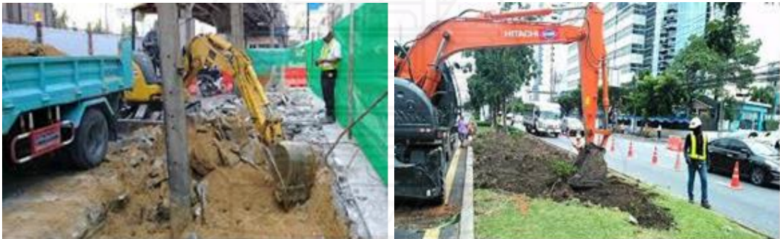
ภาพที่ 3.2 งานรื้อย้ายสาธารณูปโภค (FACILITY DEMOLITION)
