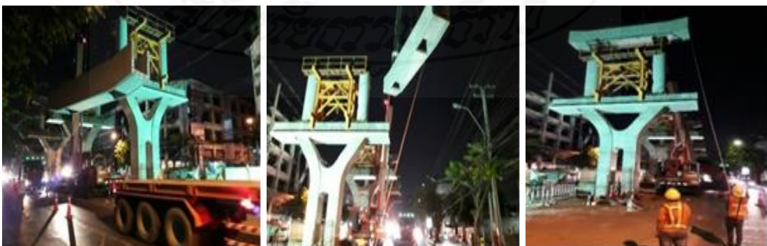
ภาพที่ 3.7 งานยกและติดตั้งคานขวางสำเร็จรูป (CROSS BEAM)
