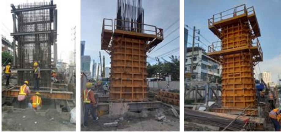
ภาพที่ 3.6 งานก่อสร้างเสา (COLUMN)
