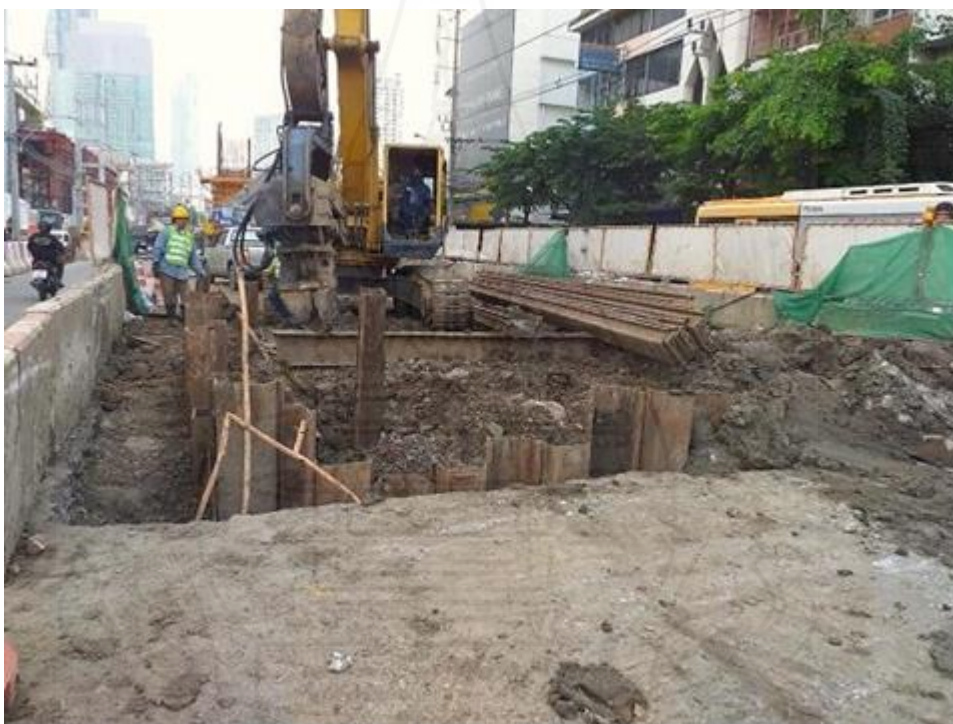
ภาพที่ 4.5 ความปลอดภัยในการตอกเข็มพืด (Sheet Pile)
