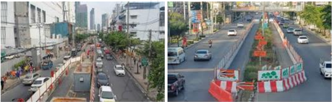
ภาพที่ 3.1 งานปิดกั้นจราจรสำหรับพื้นที่ก่อสร้าง
