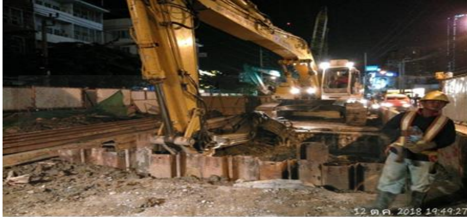
ภาพที่ 3.4 งานตอกเข็มพีต (SHEET PILE)
