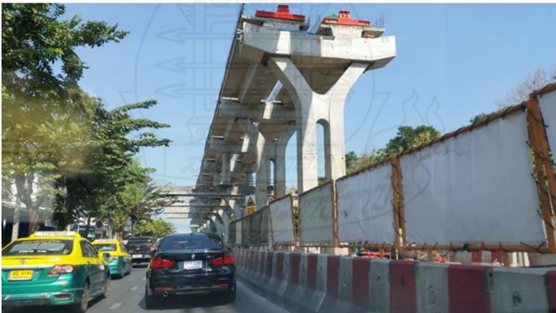
ภาพที่ 4.9 การยกและติดตั้งคานขวางสำเร็จรูป (Cross Beam)
