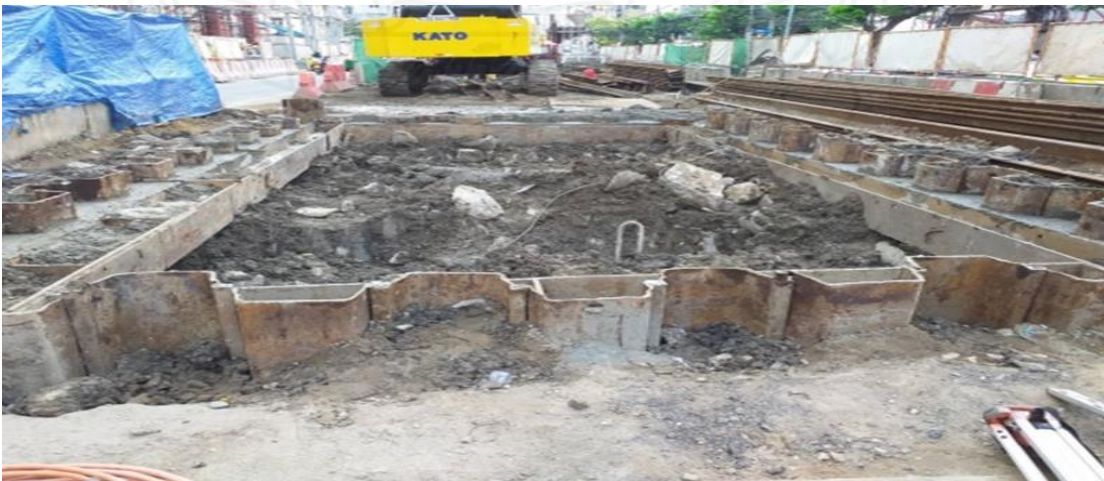
ภาพที่ 2.4 การตอกเข็มพืด (Sheet Pile)
