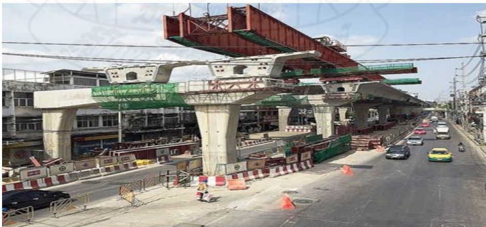
ภาพที่ 4.11 การยกและติดตั้งคานรองรับพื้นรางรถไฟ (Segment)
