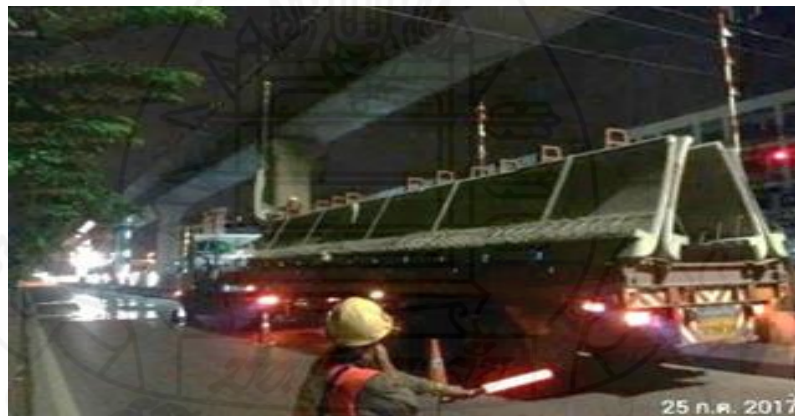
ภาพที่ 3.9 งานยกและติดตั้งผนังกันขอบทาง (PARAPET)
