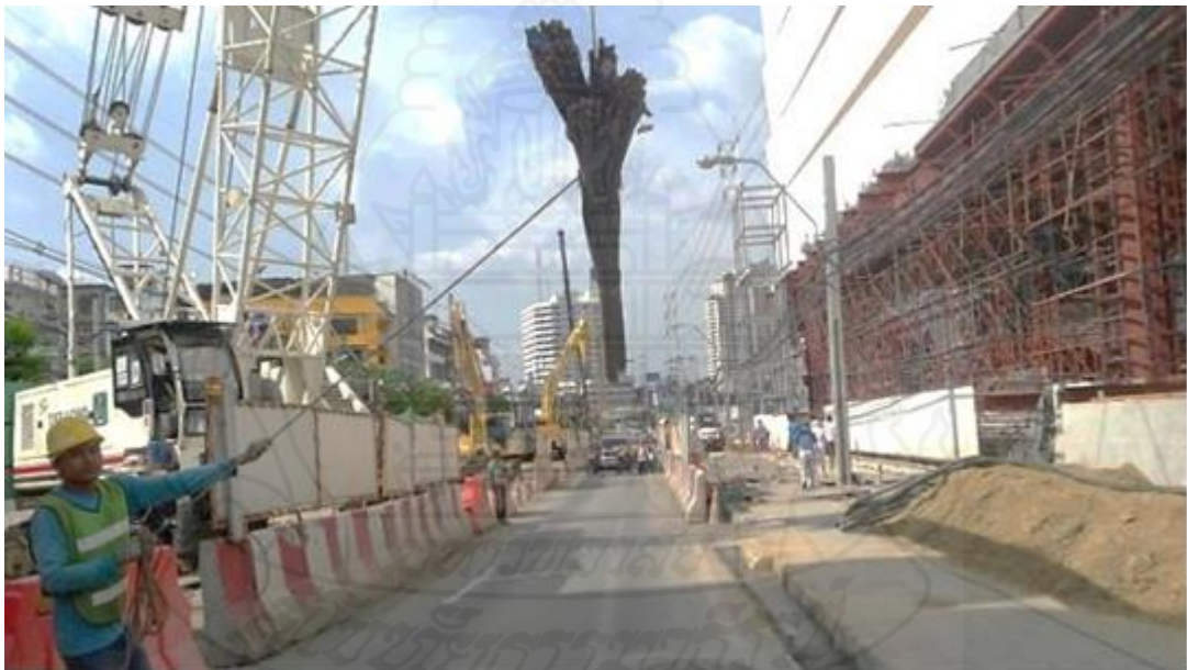
ภาพที่ 4.6 ความปลอดภัยการขนย้าย, ขนส่งวัสดุและอุปกรณ์ก่อสร้าง
