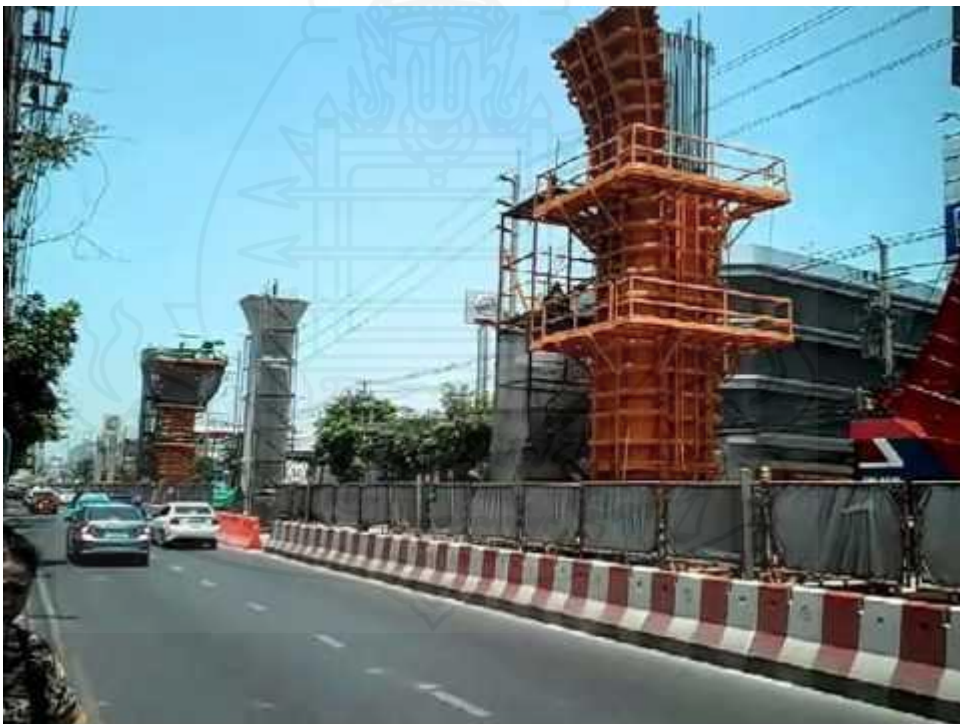
ภาพที่ 4.8 ความปลอดภัยการก่อสร้างเสา (column)
