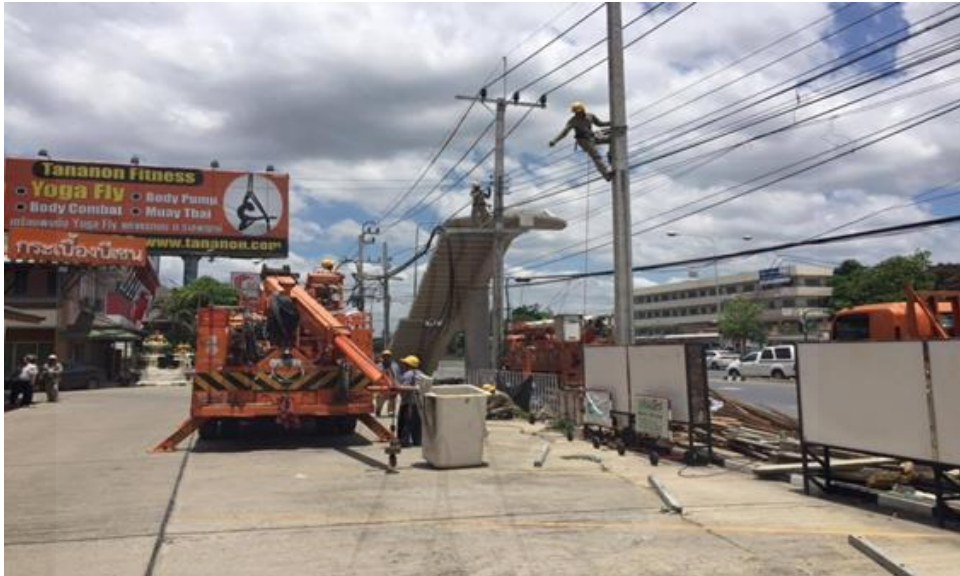
ภาพที่ 4.2 การรื้อย้ายไฟฟ้า สายไฟฟ้า
