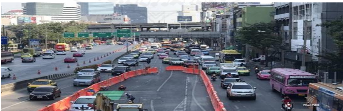
ภาพที่ 2.1 การปิดกั้นจราจรสำหรับพื้นที่ก่อสร้าง
