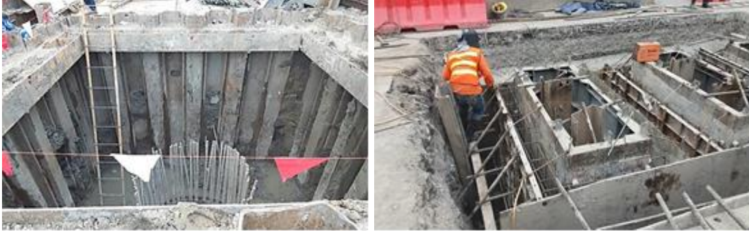
ภาพที่ 3.3 งานฐานราก (FOUNDATION)
