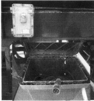
ภาพที่ 6.9 ปลั๊กไฟ 3 เฟส ใช้ในการจ่ายก๊าซปิโตรเลียมเหลวเข้าถังเก็บก๊าซ
