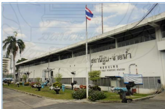
ภาพที่ 3.6 สถานีสูบน้ำ-สูบน้ำ
