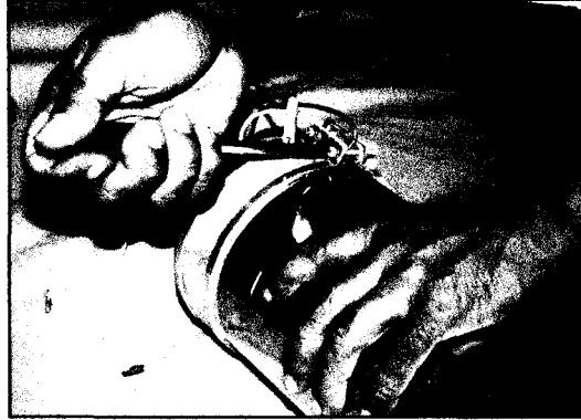
ภาพที่ 7.29 ถอดน็อตยึดลวดความร้อนออก
