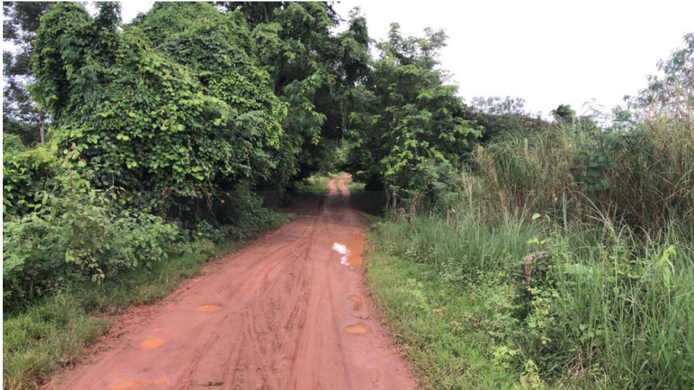
ภาพแสดงเส้นทางสัญจรบนถนนลูกรังที่ชำรุดเสียหายและไม่มีไฟฟ้าตามเส้นทางของหมู่ 1
