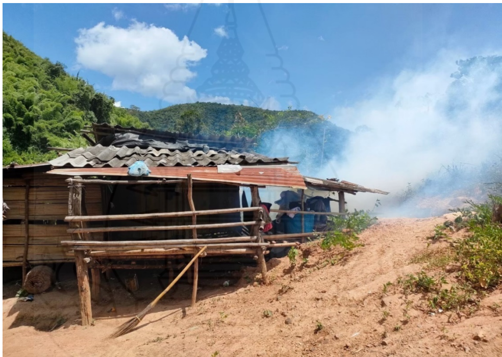
ภาพระบบไฟฟ้ายังเข้าไม่ถึงถึงบางครัวเรือนในพื้นที่ หมู่ 3
