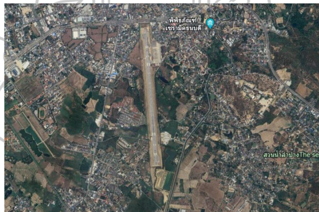
ภาพที่ 2.5 สภาพพื้นที่บริเวณท่าอากาศยานลำปาง
