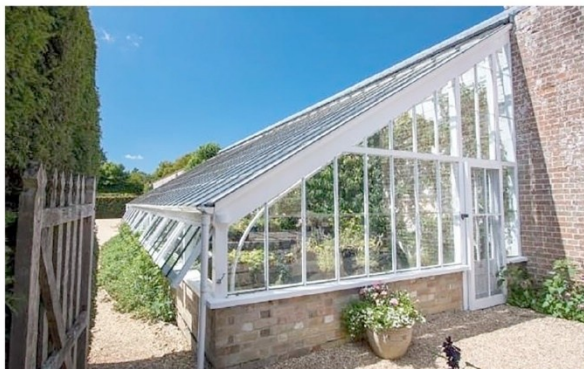
(ก) โรงเรือนที่ผนังติดกับอาคาร
