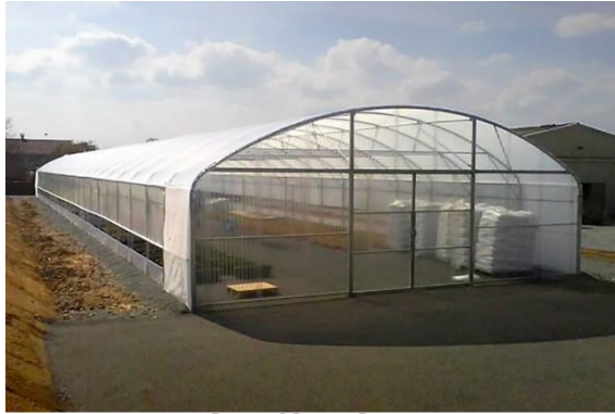
ภาพที่ 2.5 โรงเรือนหลังคาเดี่ยวแบบหลังคาโค้ง
