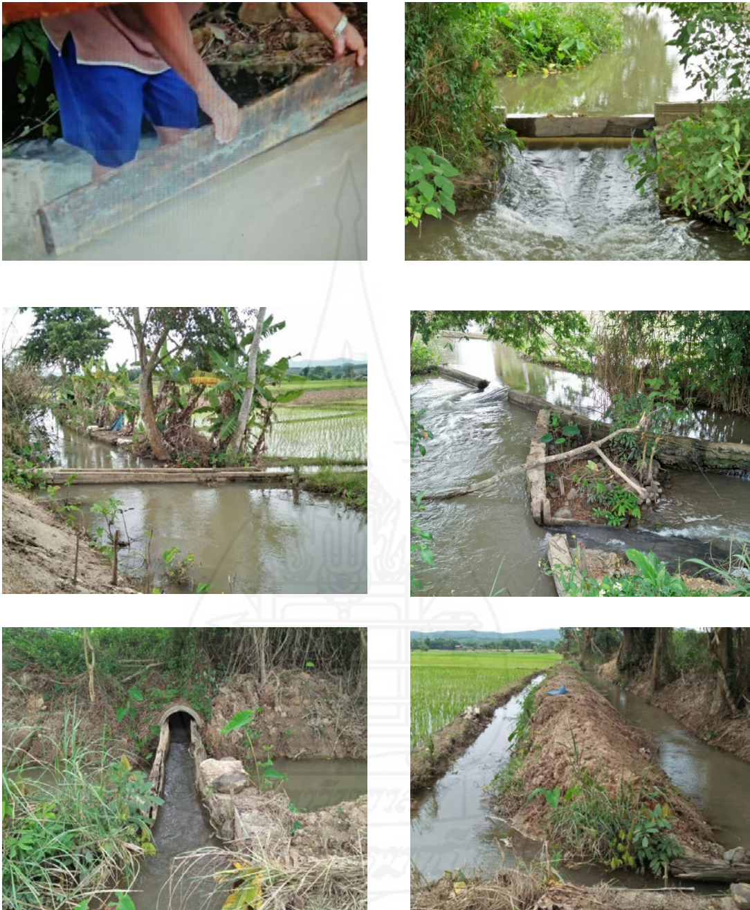
ภาพที่ 4.6 การใช้ภูมิปัญญาในการจัดสรรน้ำในแต่ละเหมืองฝายโดยการใช้ เขียง, แตะ (ประตุน้ำ)
