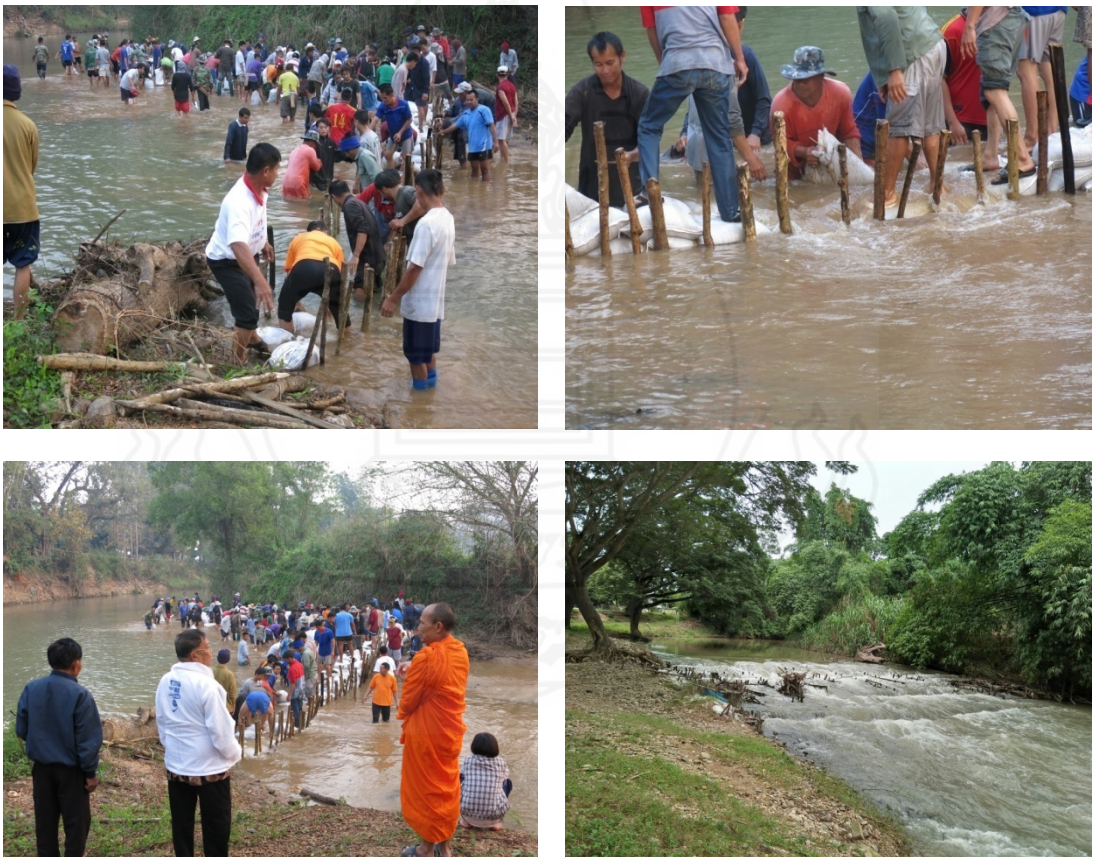
ภาพที่ 4.7 กิจกรรมการทำฝายชะลอน้ำขนาดเล็ก (ฝายมีชีวิต) กั้นลำน้ำจิมที่ผ่านหมู่บ้าน
