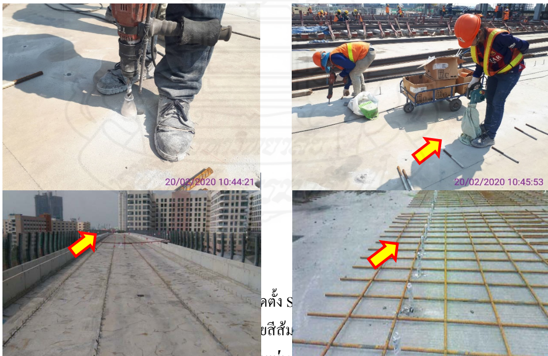
2.2.8 วางท่อนเหล็กเสริมและติดตั้งแผ่นรองวาง (Pre-stressed Concrete Sleeper
