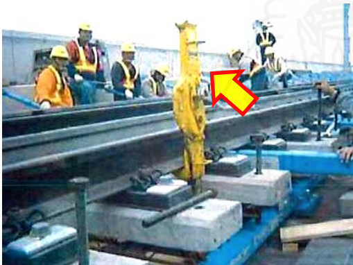
2.3.10 เครื่องตัดราง และเครื่องเจียรราง (Rail Cutting Machine and Grinding Machine)
