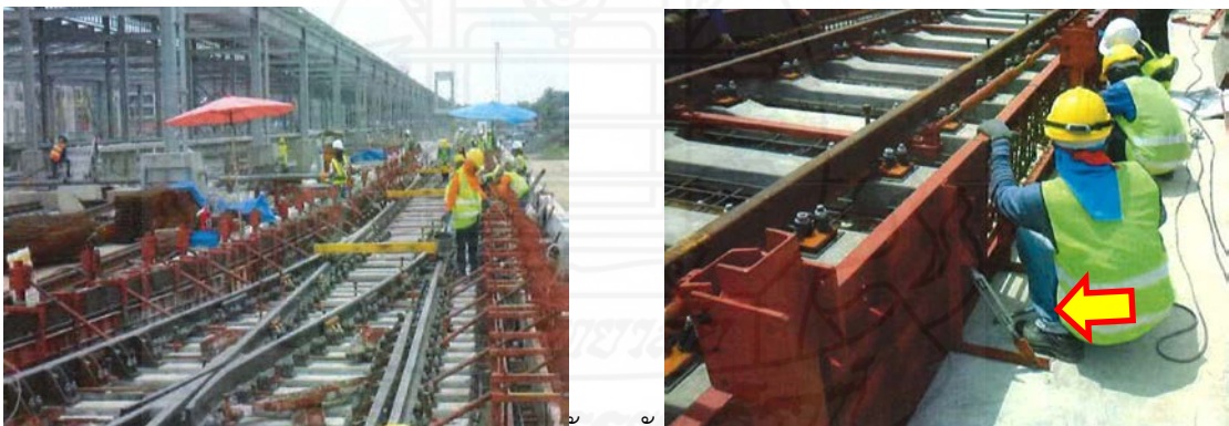
ภาพที่ 2.13 การปรับระดับและเข้าแบบหล่อ
