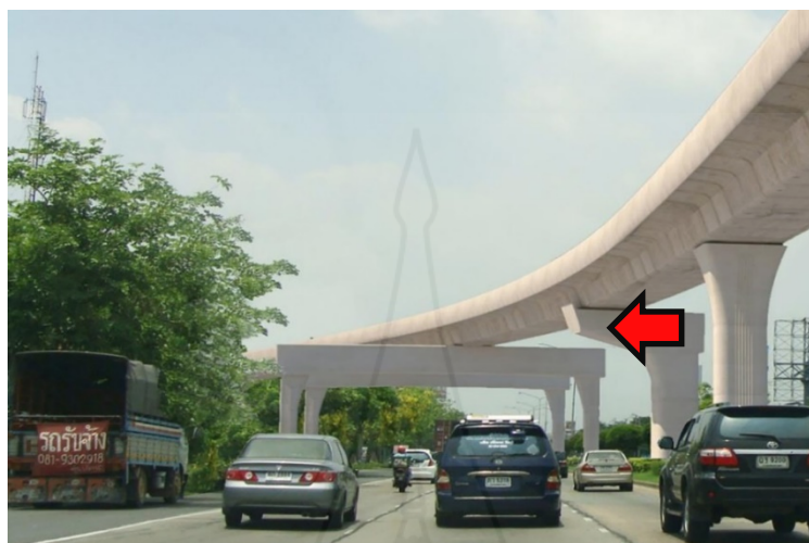
ภาพที่ 2.32 โครงสร้างยกระดับบนเสาตอม่อเดี่ยว
