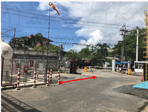
ภาพที่ 3.9 ระยะห่างระหว่างดั่งกักเก็บก๊าซปิโตรเลียมเหลวกับถนนในพื้นที่โรงงาน
