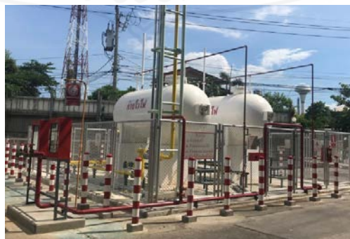
ภาพที่ 3.1 ลักษณะแท็งค์กักเก็บก๊าซปิโตรเลียมเหลว
