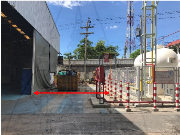
ภาพที่ 3.8 ระยะห่างระหว่างดั่งกักเก็บก๊าซปิโตรเลียมเหลวกับระบบบำบัดน้ำเสีย
