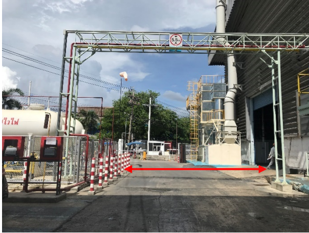
ภาพที่ 3.7 ระยะห่างระหว่างดั่งกักเก็บก๊าซปิโตรเลียมเหลวกับบริเวณประตูโรงงาน
