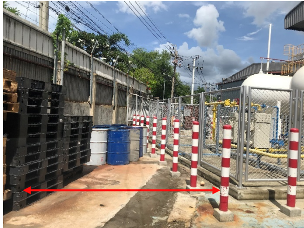
ภาพที่ 3.10 ระยะห่างระหว่างถังกักเก็บก๊าซปิโตรเลียมเหลวกับรั้วมูมซ้าย
