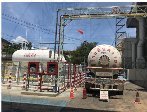
ภาพที่ 3.14 รถจ่ายก๊าซเข้ามาเติมก๊าซในโรงงาน
