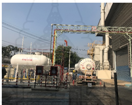
ภาพที่ 3.3 ลักษณะท่อ (สีเหลือง) จากแท่งค้ำไปยังกระบวนการผลิต
