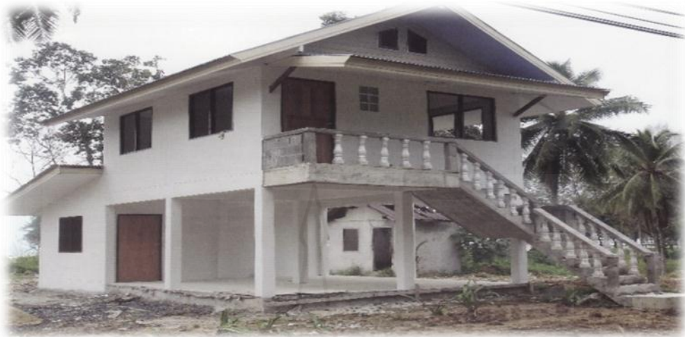
ภาพที่ 4.7 ภาพบ้านพักถาวรที่สร้างเสร็จสมบูรณ์
