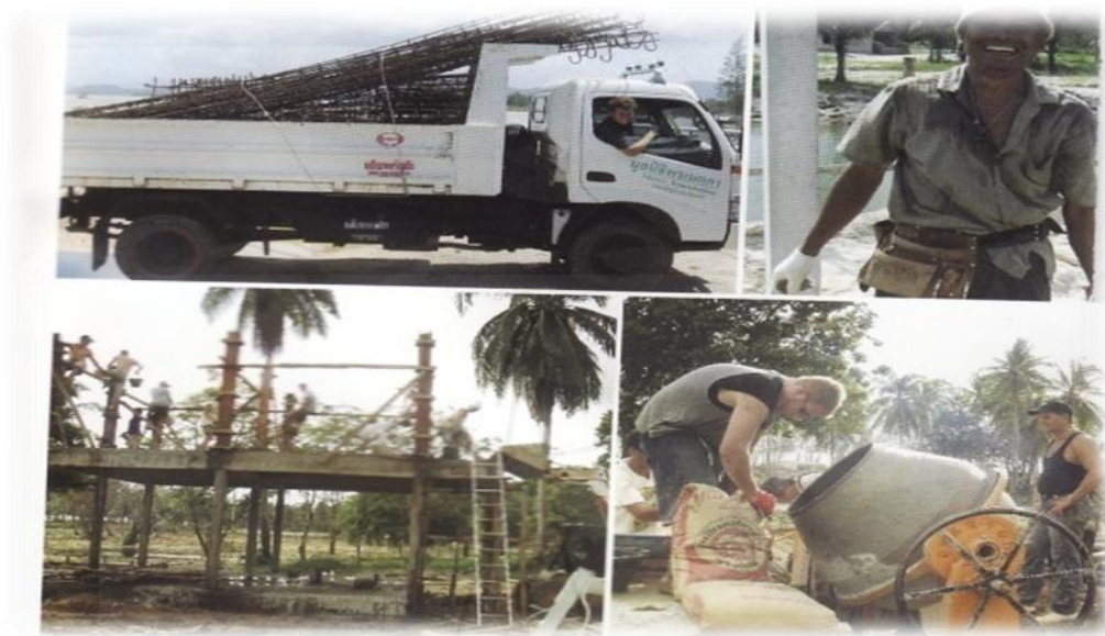
ภาพที่ 4.5 ภาพการดำเนินการในการก่อสร้าง
