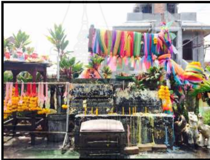
ศาลหลักเมืองเมืองใหม่ปัจจุบัน (กำลังก่อสร้างศาลาขึ้นใหม่)
