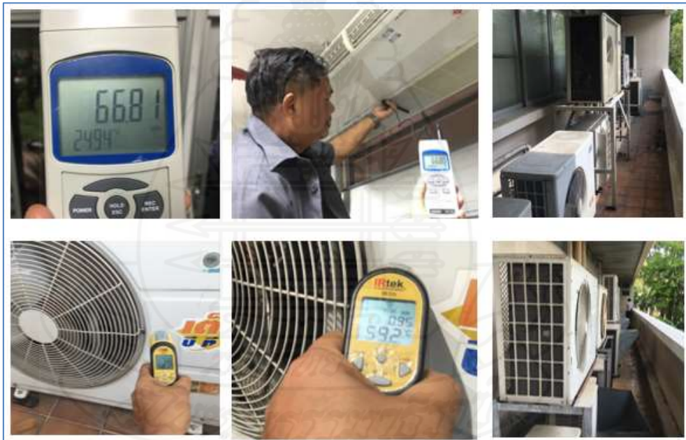
ภาพที่ 4.16 การตรวจวัดประสิทธิภาพเครื่องปรับอากาศของโรงพิมพ์
