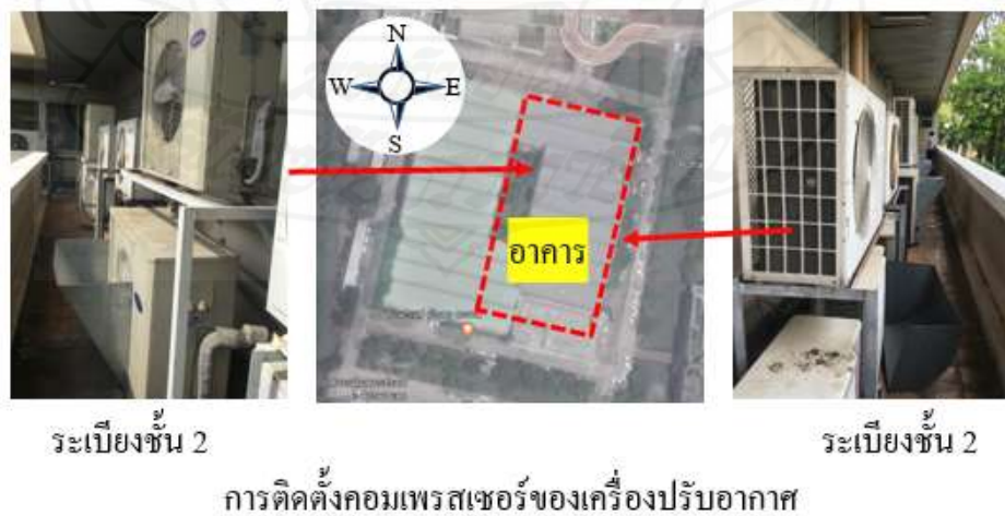
ภาพที่ 4.2 ลักษณะการติดตั้งคอมเพรสเซอร์เครื่องปรับอากาศที่ระเบียงชั้น 2
