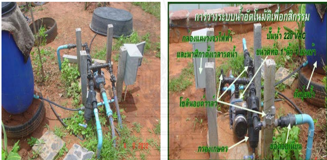
ภาพแสดง : การติดตั้งระบบปั้มน้ำ ถังเติมปุ๋ย และชุดนาฬิกาตั้งเวลาให้น้ำอัตโนมัติ
